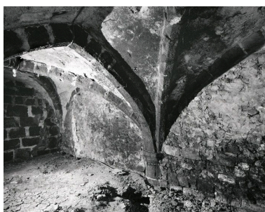
La cave médiévale : le pilier central, aujourd'hui inclus dans la maçonnerie. Phot. Stéphane Asseline IVR11_20057700532X
