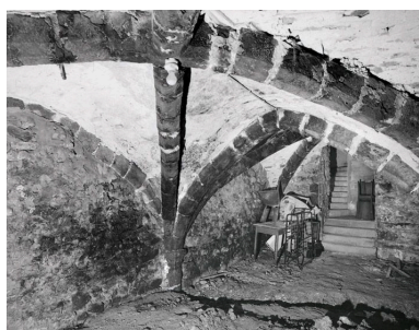
La cave médiévale : vue depuis l'angle sud-ouest. Phot. Stéphane Asseline IVR11_20057700531X
