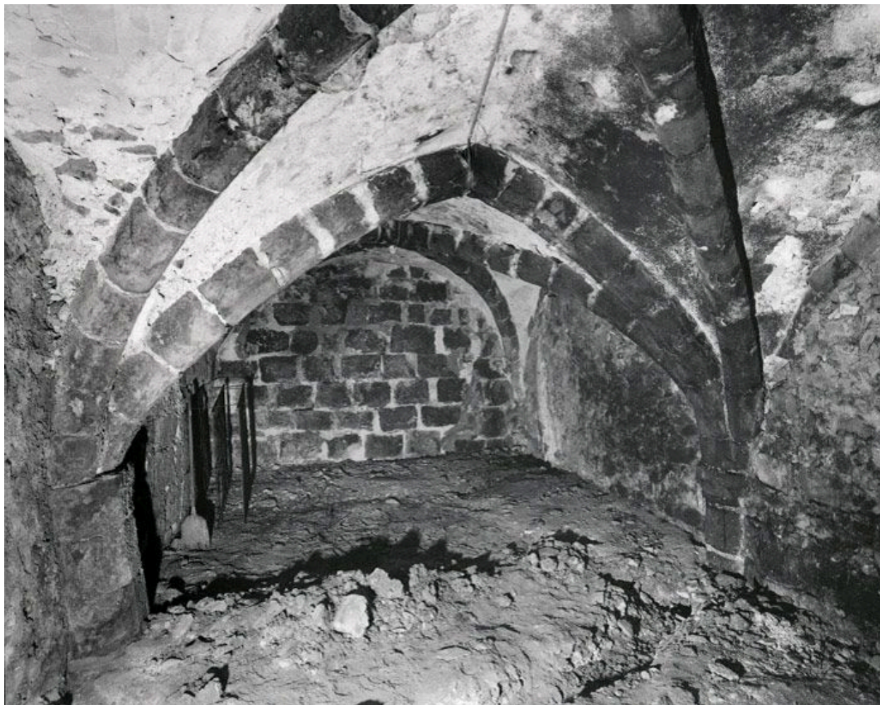
La cave médiévale : vue depuis l'angle sud-est.
