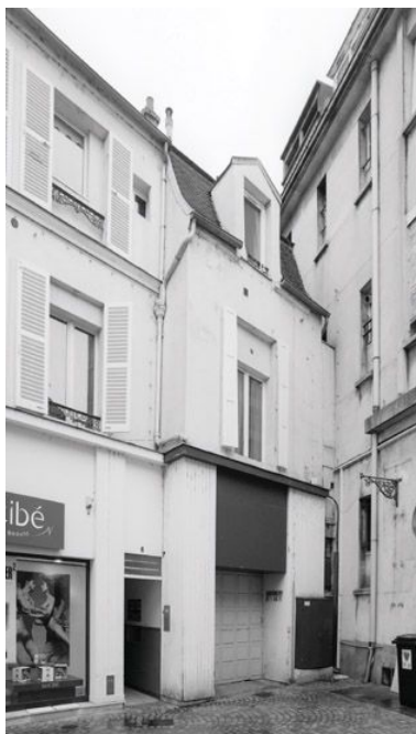
Vue de la façade. Phot. Stéphane Asseline IVR11_20057700529X
