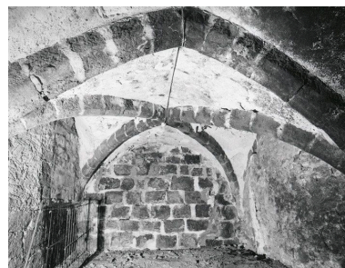
La cave médiévale : vue depuis l'entrée. Phot. Stéphane Asseline IVR11_20057700530X
