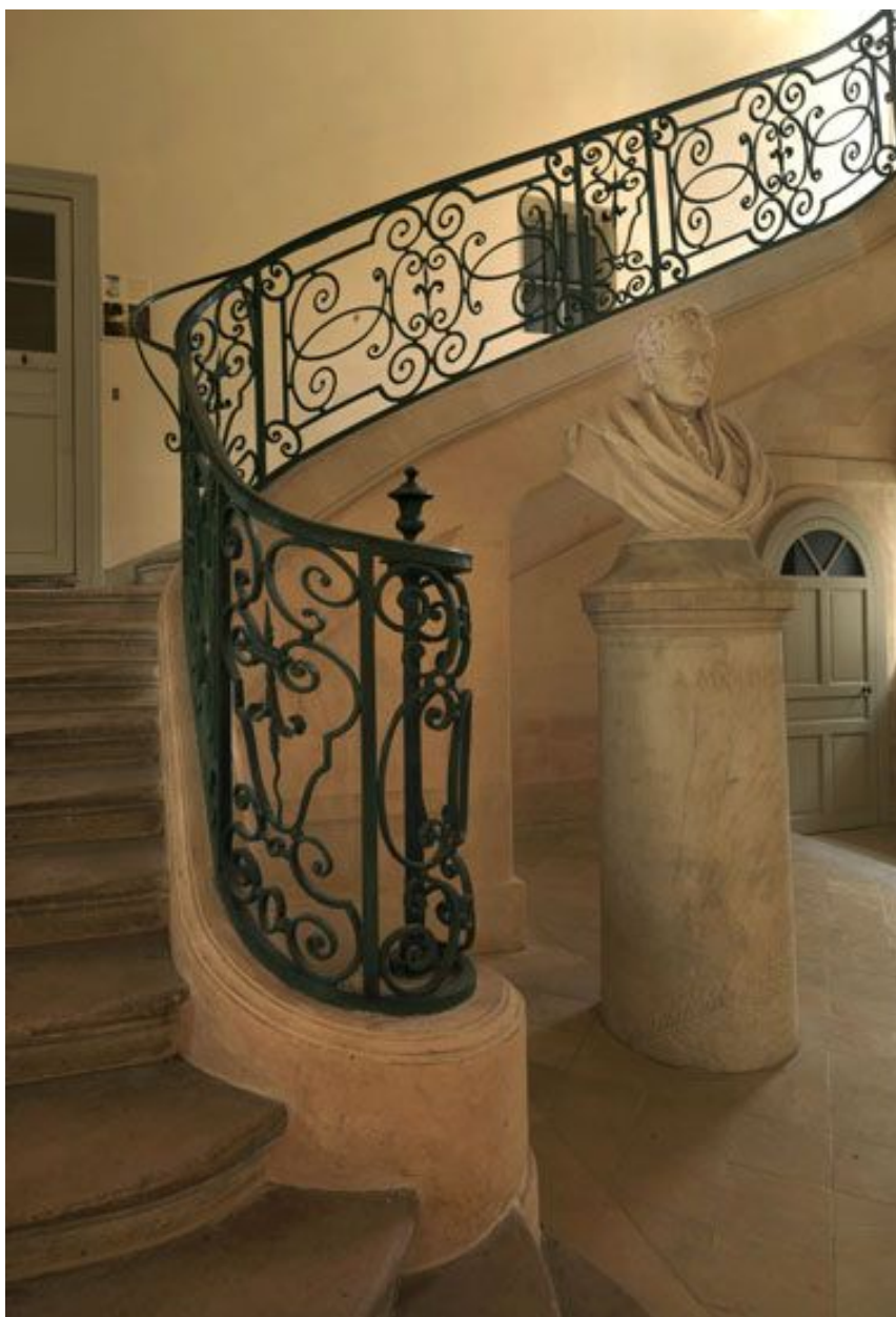
Enroulement de départ et première volée de l'escalier des Grands Hommes.
