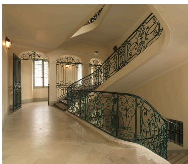
Panneau et pilastres rampants de l'escalier des Grands Hommes.
