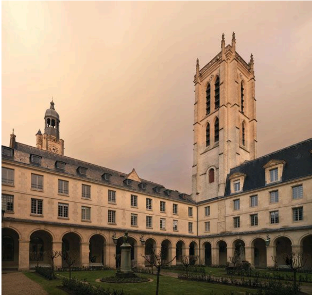
Vue de l'ancien cloître et de la tour Clovis.
