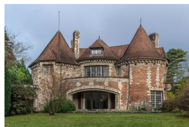
Villa des Tourneroches, façade sud Phot. Kruszyk Laurent IVR11_20249201020NUC4A
