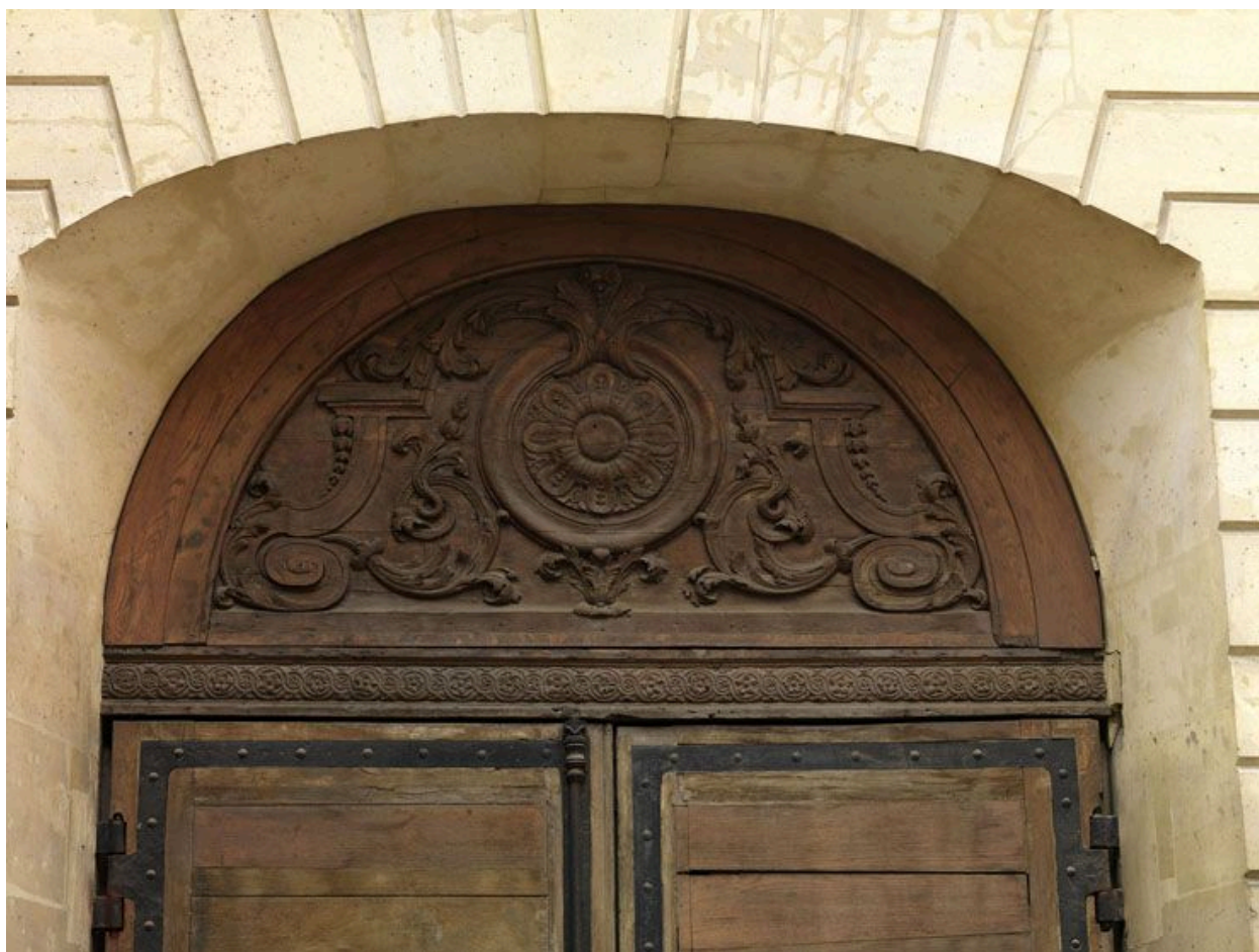
Vue du tympan de la porte cochère côté cour.
