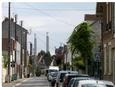
Vue des cheminées de la centrale thermique de Porcheville depuis la rue Alphonse Durand. Phot. Philippe Ayrault IVR11_20167800414NUC4A
