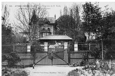
Vue d'ensemble depuis la rue. IVR11_20029101090X
