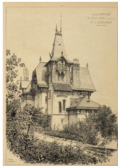
Vue de trois-quarts (façades latérale ouest et arrière). IVR11_20039101206XA
