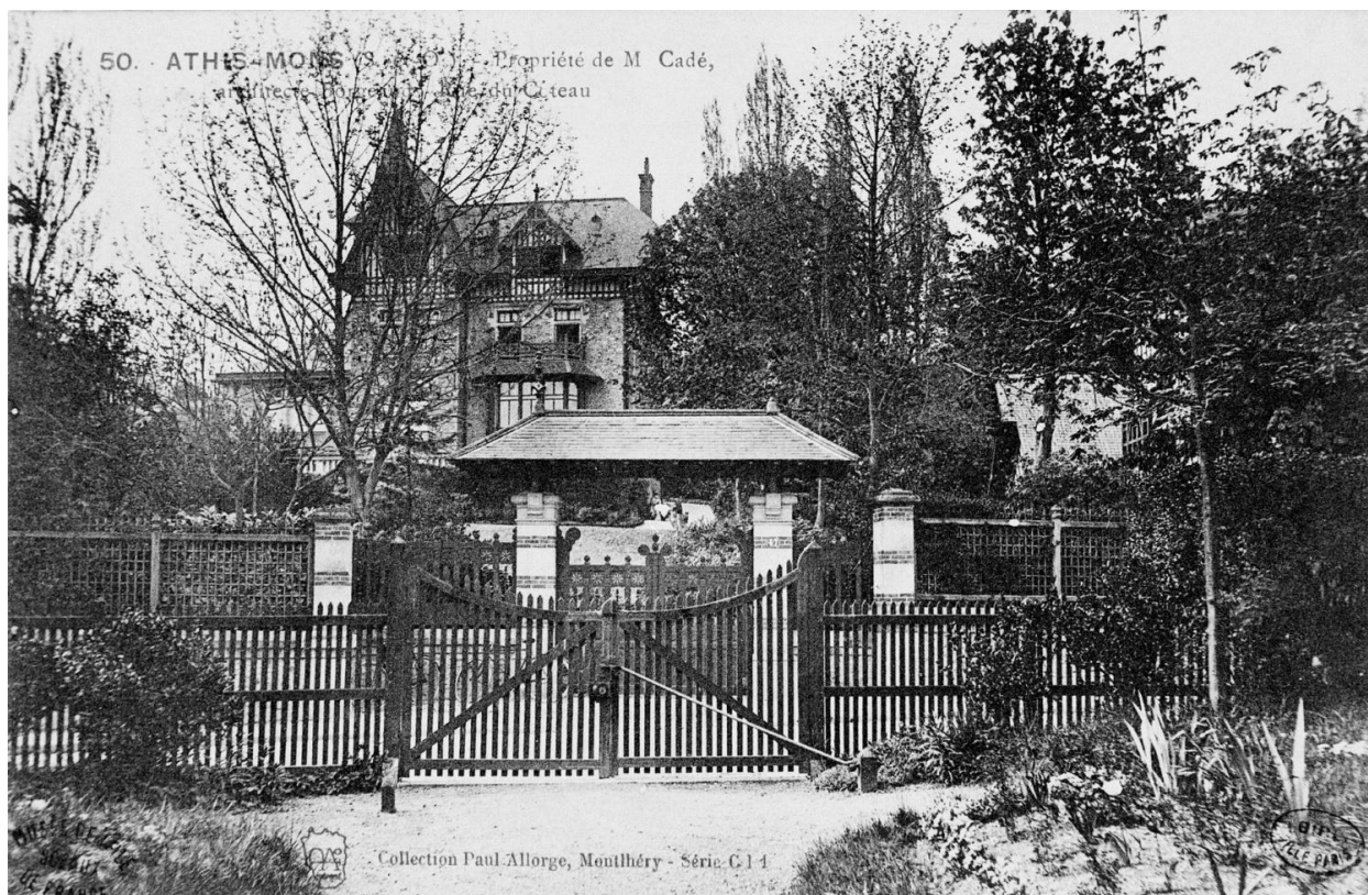
Vue d'ensemble depuis la rue.
