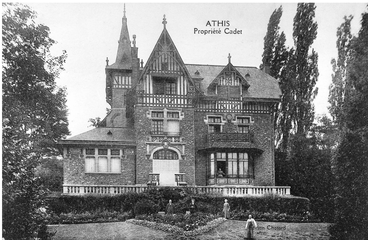
Vue de la façade antérieure, donnant sur le parc ; vers 1920.
