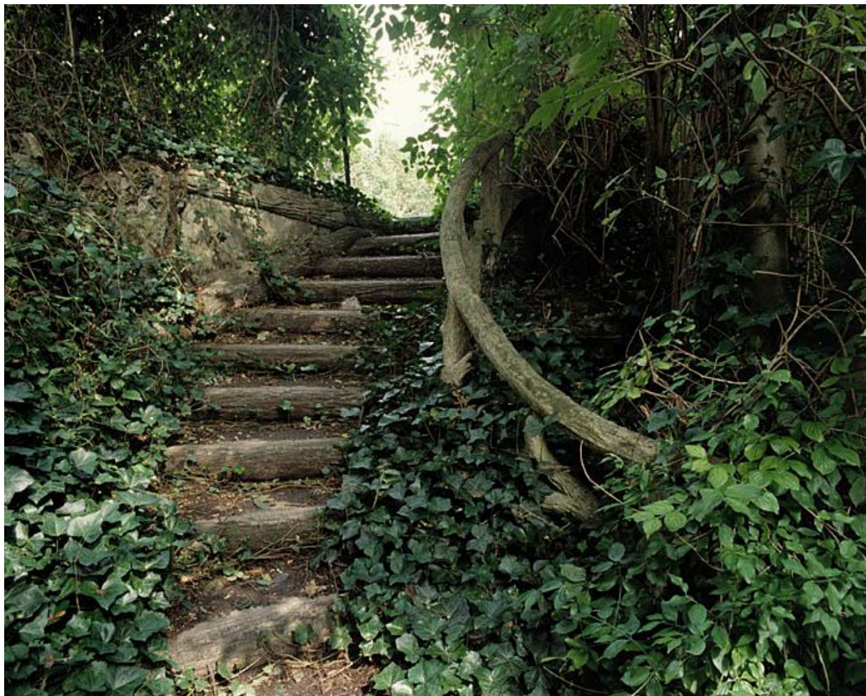
Vestige des aménagements du parc : escalier en faux bois écoté débouchant sur l'avenue Constance.
