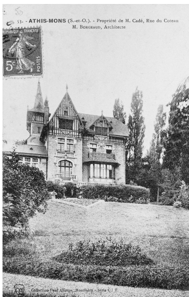
Vue d'ensemble. IVR11_20029101171X
