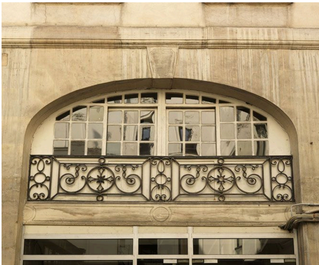
Vue d'un garde-corps, 22 rue du Sentier.
