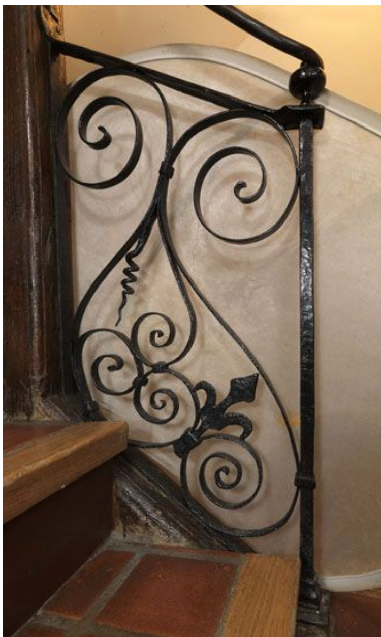
Vue d'un balustre avec une fleur de lys. L'escalier est en bois et ne comporte que deux panneaux en ferronnerie dont celui-ci, 40, rue Pastourelle.
