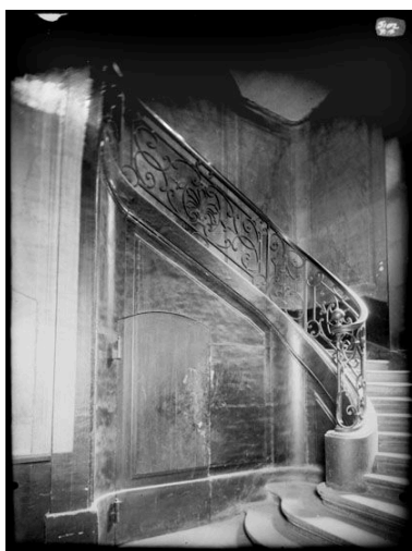
Vue d'ensemble de l'escalier A, 8, rue Vivienne. Photographie. (Commission du Vieux Paris) Repro. Jean-François Dontenwill IVR11_20097501120NUC1
