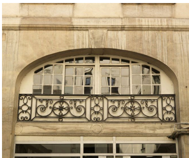
Vue d'un garde-corps, 22 rue du Sentier. Phot. Laurent Kruszyk IVR11_20097501431NUC4A
