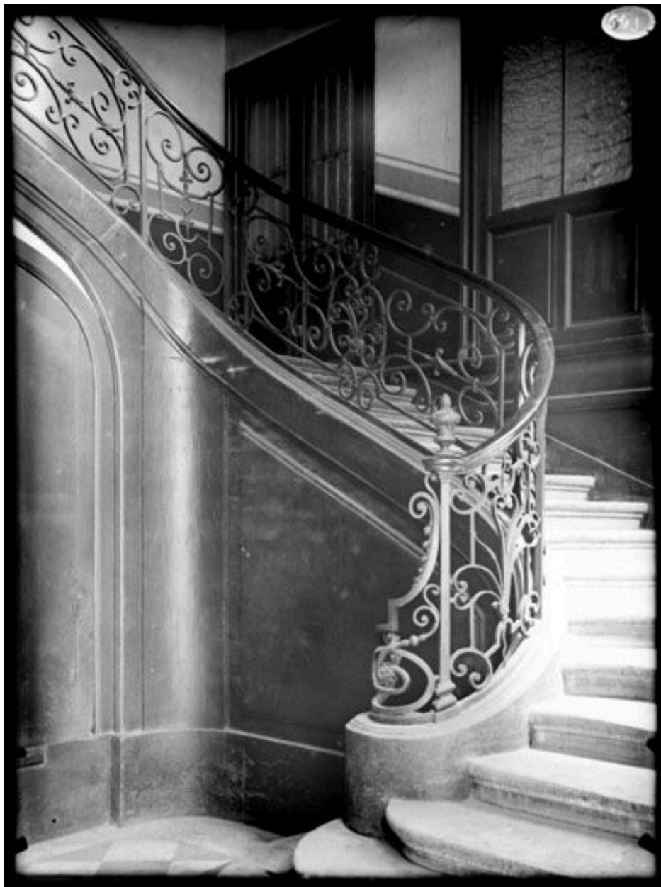
Vue d'ensemble de l'escalier B, 8 rue Vivienne. Photographie. (Commission du Vieux Paris)
