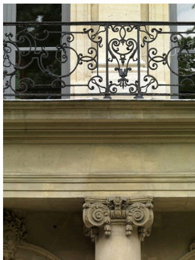
Pilastre du balcon de l'avant corps de la façade sur jardin, hôtel de Rothelin Charolais, 101, rue de Grenelle. Phot. Laurent Kruszyk IVR11_20097501055NUC4A
