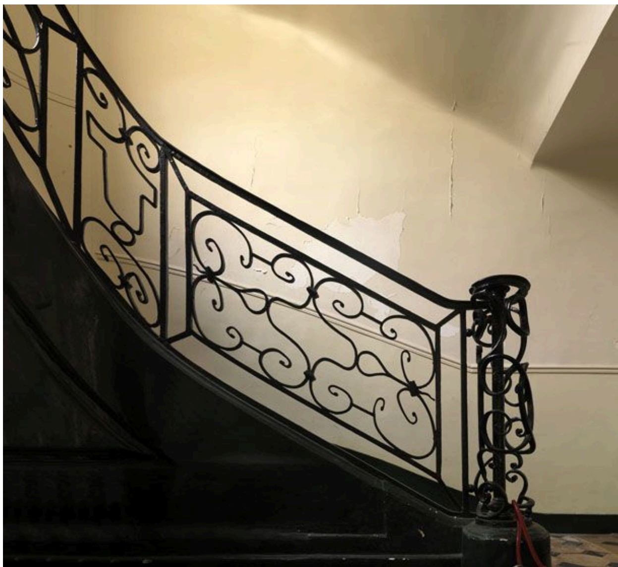
Départ de l'escalier A, 99, rue du Bac.
