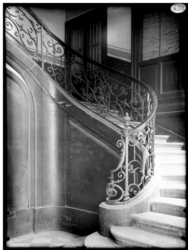
Vue d'ensemble de l'escalier B, 8 rue Vivienne. Photographie. (Commission du Vieux Paris) Repro. Jean-François Dontenwill IVR11_20097501121NUC1
