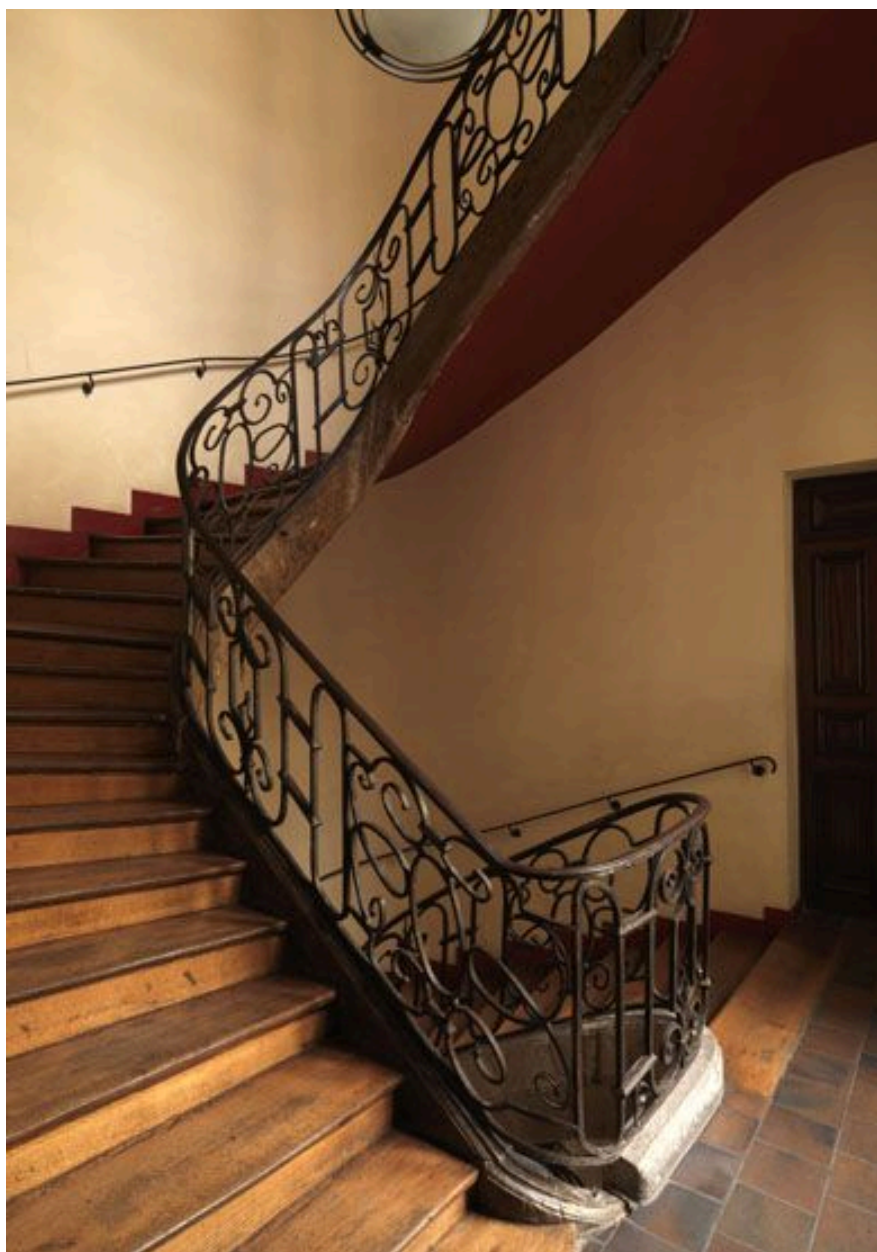
Deuxième et troisième volées composées d'éléments disparates, 11, rue du Fauconnier.
