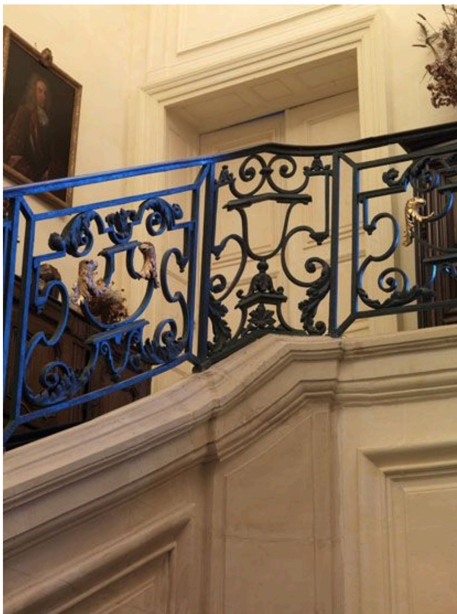
Pilastre de transition entre le rampant et le palier.
