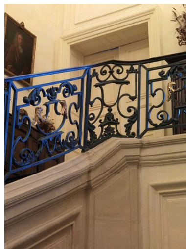
Pilastre de transition entre le rampant et le palier. Phot. Laurent Kruszyk IVR11_20107500230NUC4A
