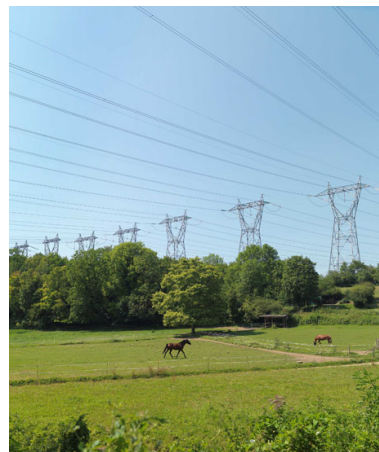
Rangée de pylones électriques à haute tension dans un champ. Phot. Philippe Ayrault IVR11_20127700659NUC4A
