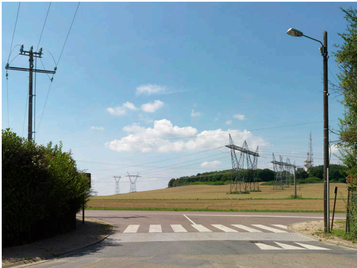
Pylones électriques haute tension dans un champ. Au premier plan un passage piéton, un lampadaire et un poteau électrique.
