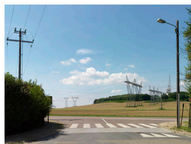
Pylones électriques haute tension dans un champ. Au premier plan un passage piéton, un lampadaire et un poteau électrique. Phot. Philippe Ayrault IVR11_20147700396NUC4A
