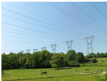
Rangée de pylones électriques à haute tension dans un champ. Phot. Philippe Ayrault IVR11_20127700658NUC4A
