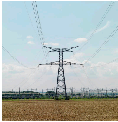
Pylones et lignes électriques haute tension. Phot. Philippe Ayrault IVR11_20147700398NUC4A
