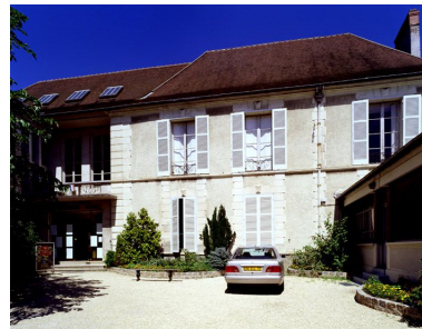
Elévation sud (façade sur cour). Phot. Stéphane Asseline IVR11_20037700632VA
