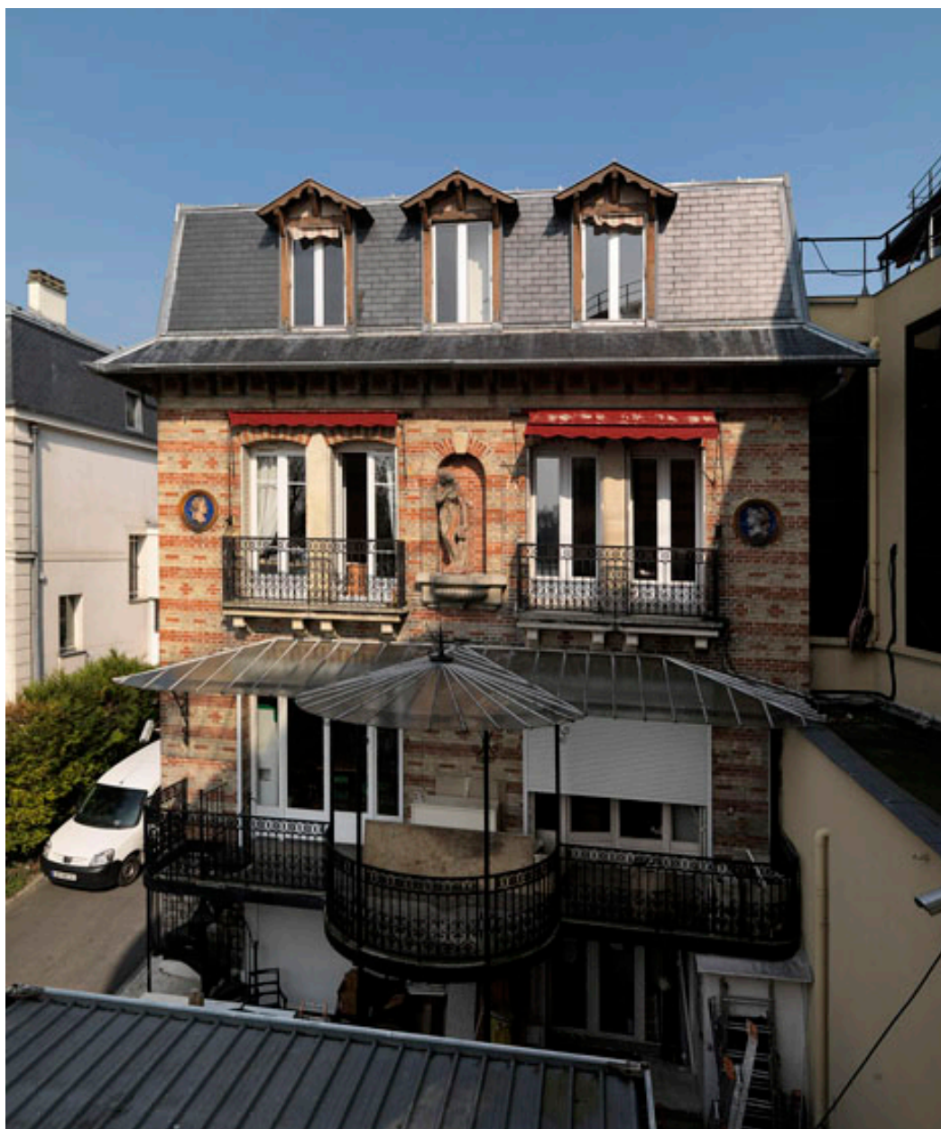
Vue d'ensemble de la façade donnant sur le lac.
