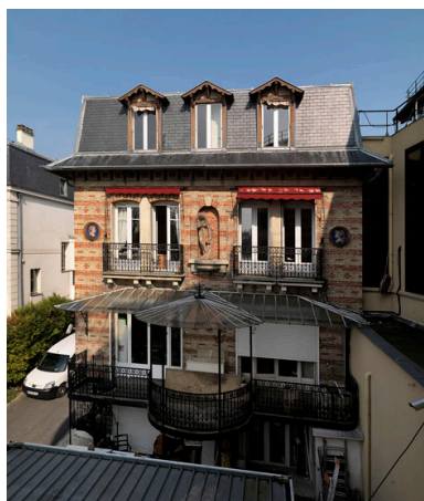
Vue d'ensemble de la façade donnant sur le lac. Phot. Jean-Bernard Vialles IVR11_20099500618NUC4A
