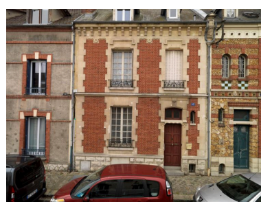
Façade du 15, en brique et pierre Phot. Laurent Kruszyk IVR11_20167800411NUC4A
