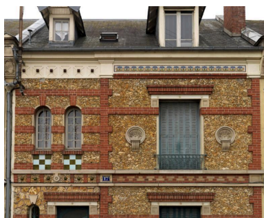
Décor de l'étage du 17. le décor cumule meulière rocaillée, brique, céramique, sculpture. Phot. Laurent Kruszyk IVR11_20167800406NUC4A
