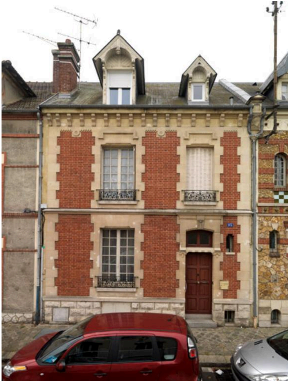
Façade du 15 rue Alphonse Durand.
