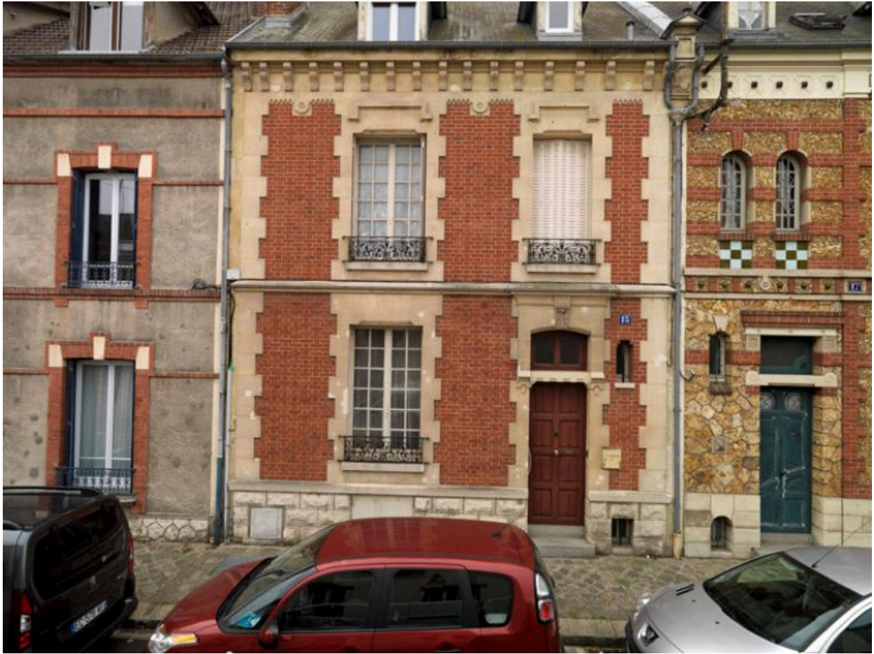
Façade du 15, en brique et pierre
