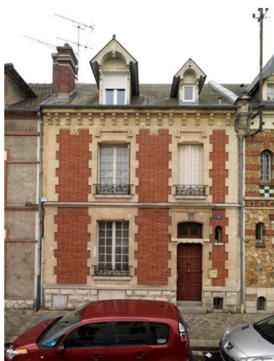
Façade du 15 rue Alphonse Durand. Phot. Laurent Kruszyk IVR11_20167800410NUC4A
