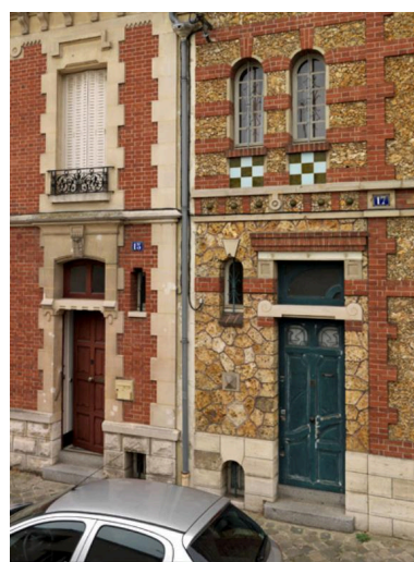
Détail de l'entrée du 17. La meulière y est traitée en "opus incertum" Phot. Laurent Kruszyk IVR11_20167800405NUC4A
