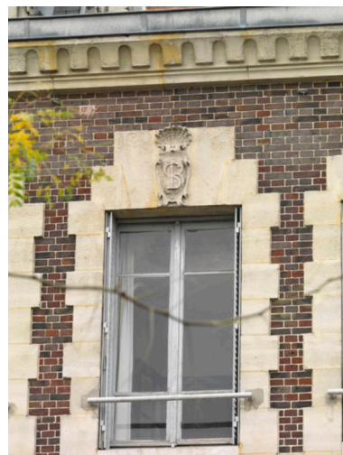
Le décor des baies est particulièrement soigné, ici une agrafe avec un décor de cuir découpé et de coquille Phot. Laurent Kruszyk IVR11_20177801408NUC4A
