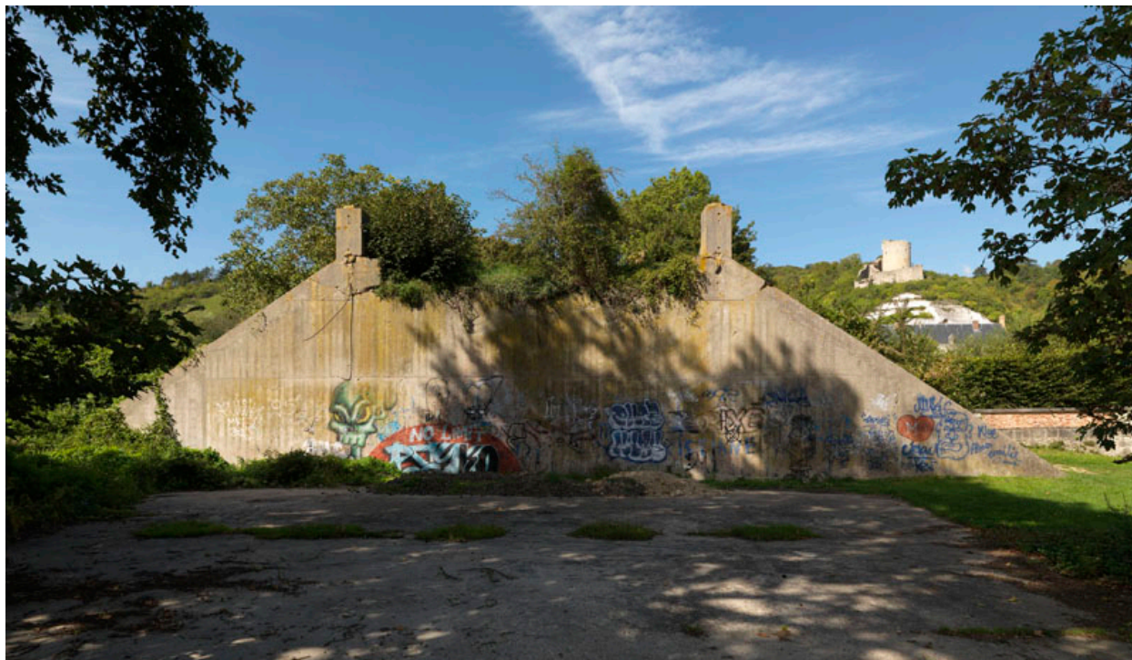
Pile en béton du pont à tablier suspendu détruit en 1944.
