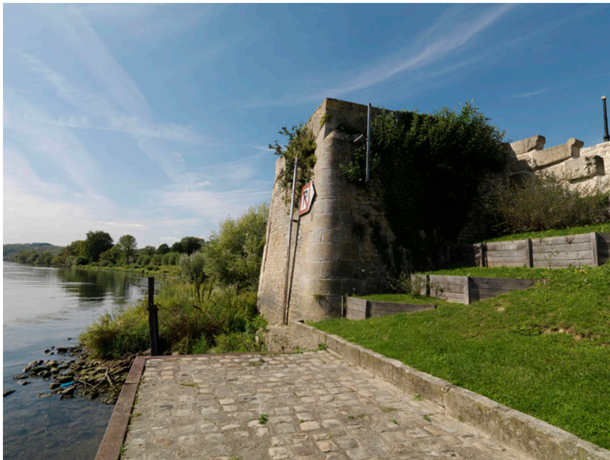
Pile du pont suspendu détruit en 1914.
