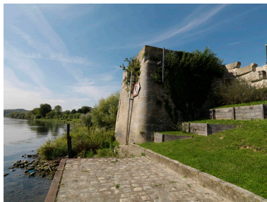
Pile du pont suspendu détruit en 1914. Phot. Laurent Kruszyk IVR11_20119500875NUC4A
