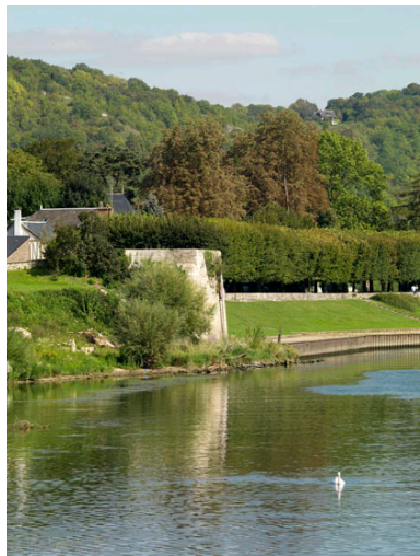
Pile du pont suspendu détruit en 1914 vue depuis les berges de La Roche-Guyon vers l'amont. Phot. Laurent Kruszyk IVR11_20119500877NUC4A
