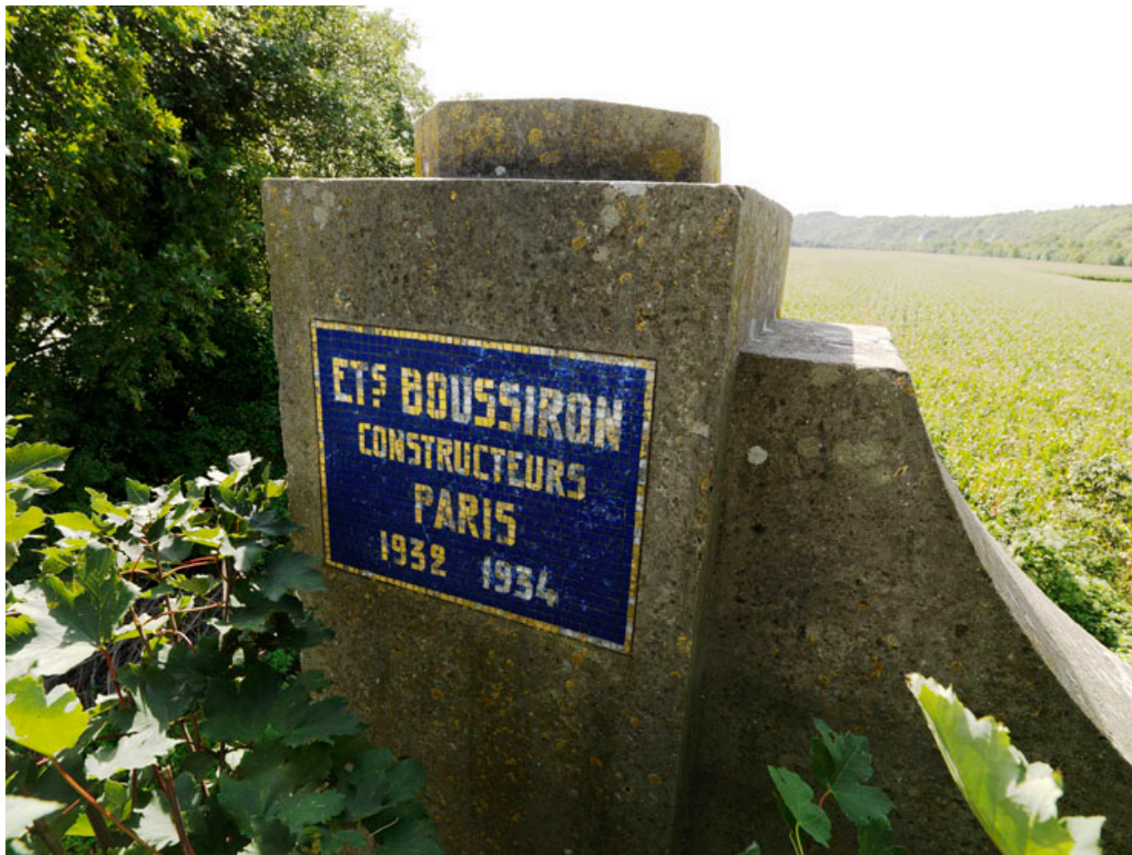
Plaque sur la pile du pont indiquant le nom du constructeur et la date des travaux.
