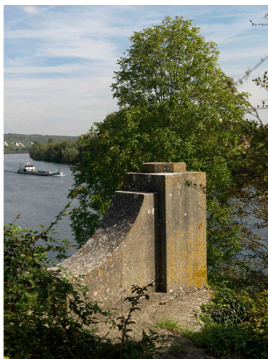
Pile en béton du pont détruit en 1944 vue depuis les berges de La Roche-Guyon vers l'amont. Phot. Laurent Kruszyk IVR11_20119500879NUC4A
