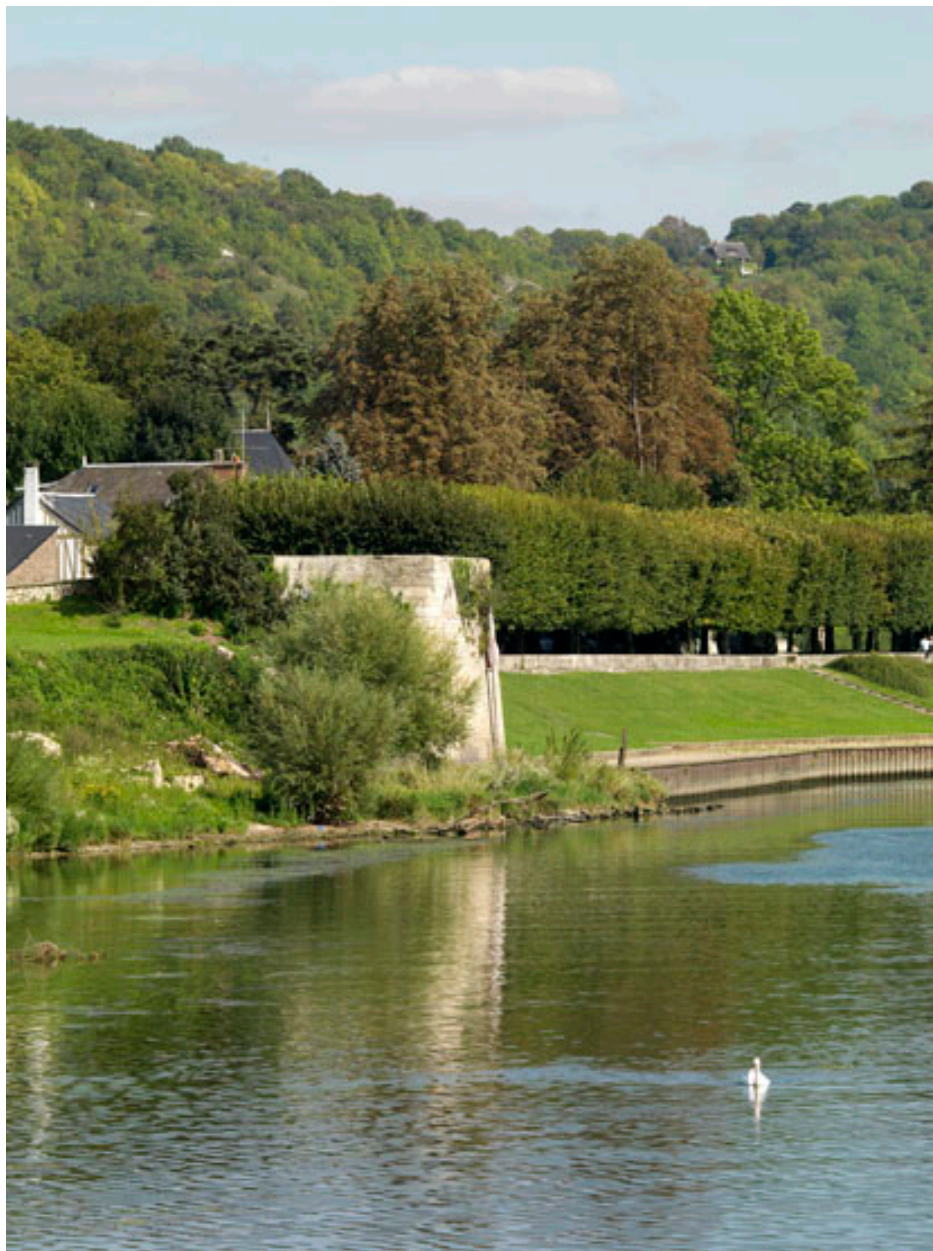
Pile du pont suspendu détruit en 1914 vue depuis les berges de La Roche-Guyon vers l'amont.
