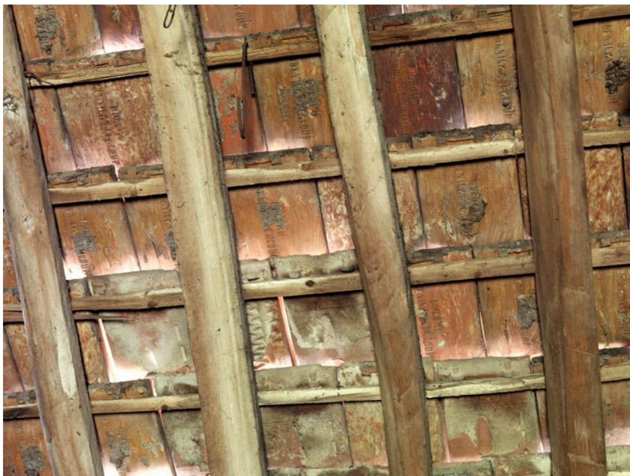
Détail de la couverture de l'atelier.
