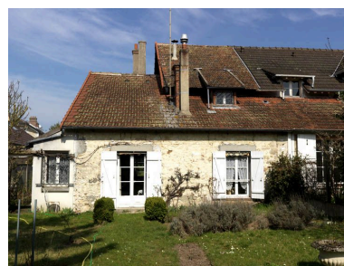
Façade arriere, extension postérieure a la construction de l'atelier.
