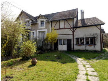
Vue générale de l'atelier du charpentier Canteau.
