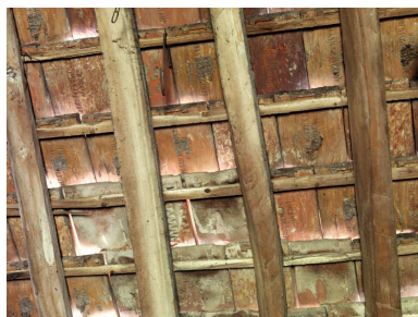
Détail de la couverture de l'atelier.
