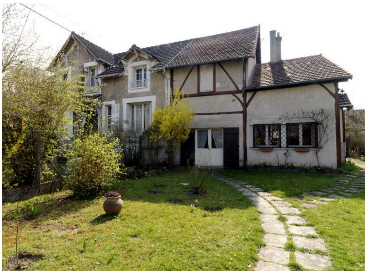
Vue générale de l'atelier du charpentier Canteau.
