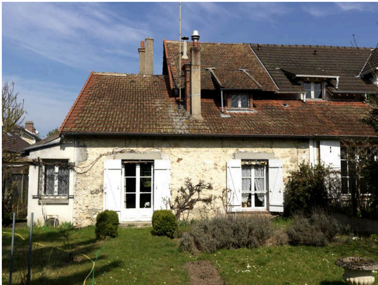
Façade arriere, extension postérieure a la construction de l'atelier.
