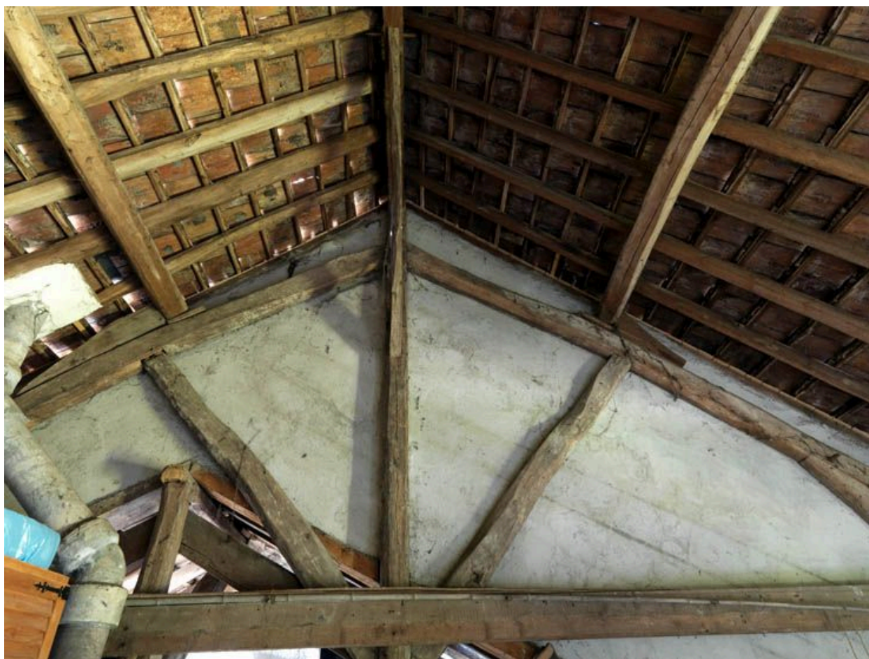
Charpente de l'atelier.
