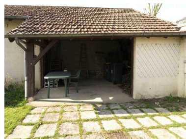
Atelier du charpentier Canteau, appentis.
