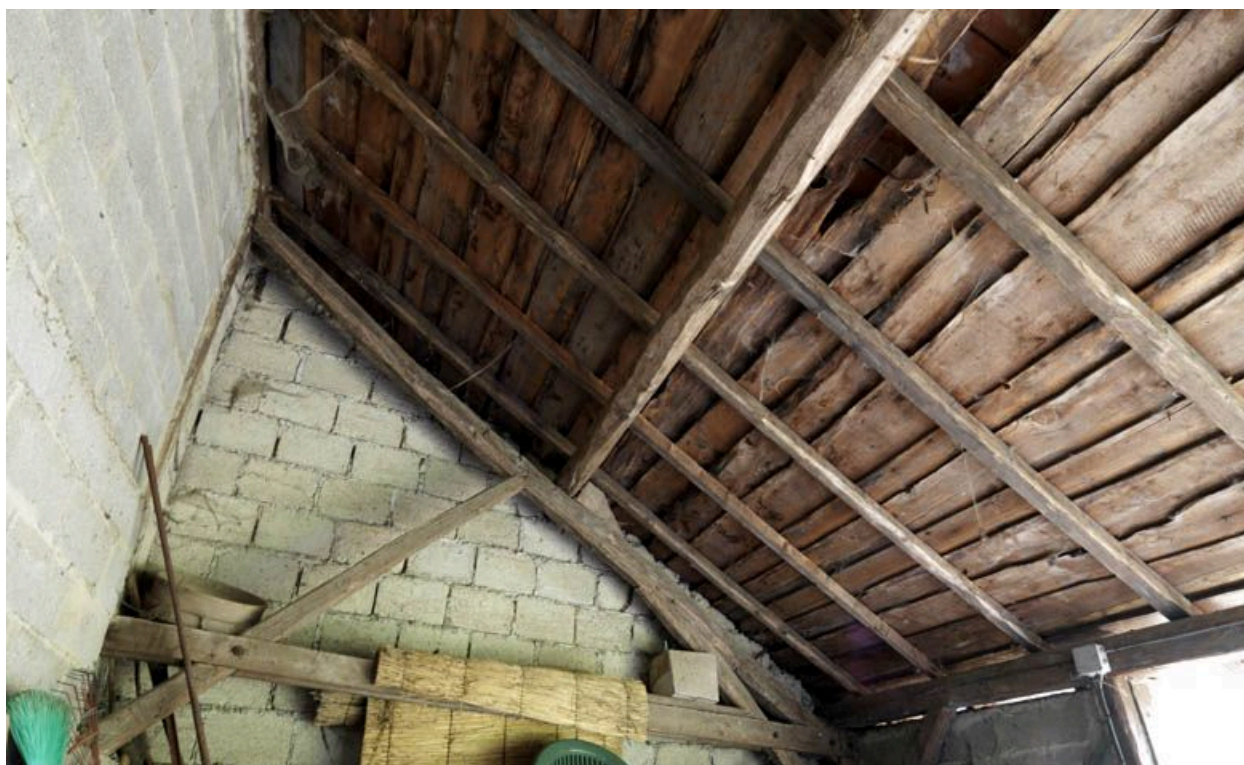
Appentis, détail de la charpente.
