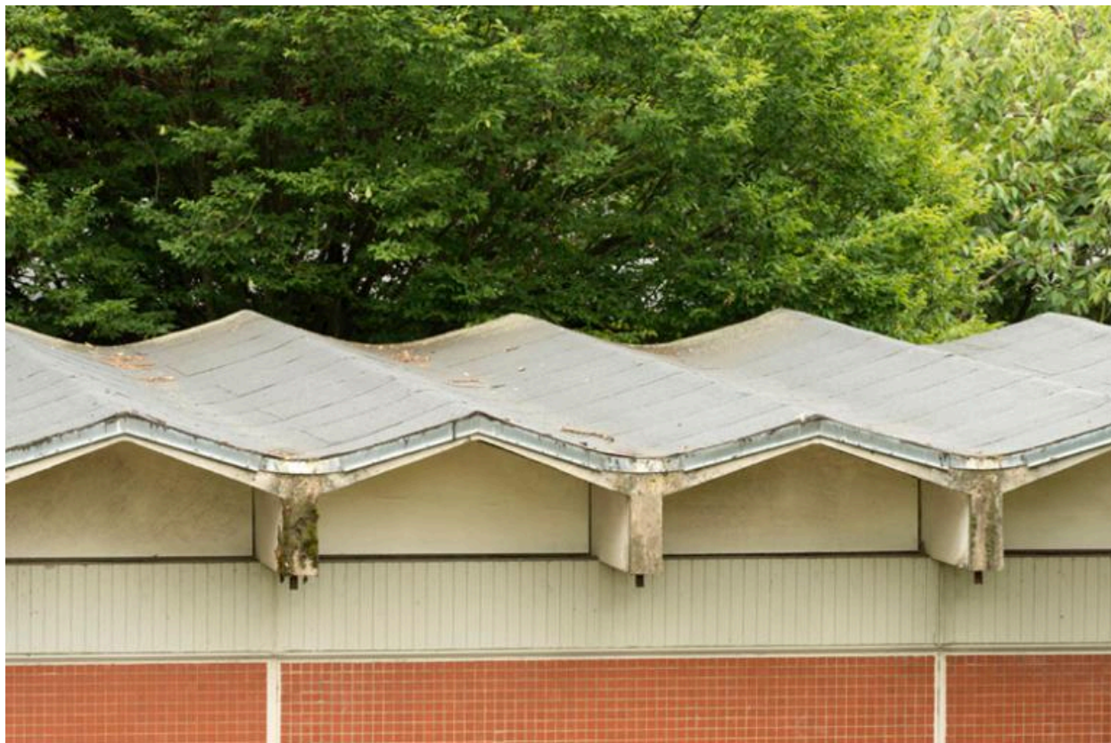
Les éléments modulaires du toit.
