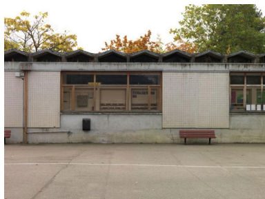
La façade sur cour des classes maternelles. Phot. Laurent Kruszyk IVR11_20167800608NUC4A
