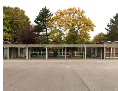
La galerie passe au devant d'un jardin au centre de l'école Rousseau. Phot. Laurent Kruszyk IVR11_20167800609NUC4A
