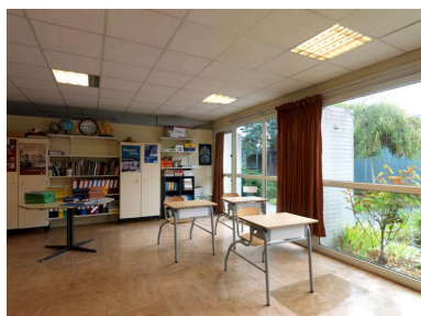
Vue d'une classe donnant sur un patio. L'adjonction du double-plafond empêche l'éclairage zénital d'origine.
