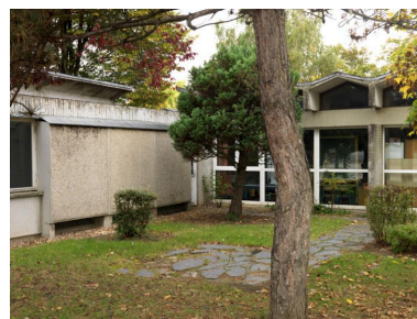
Le jardin central de l'école Rousseau. On voit que les classes sont installées en quinconce deux par deux. Phot. Laurent Kruszyk IVR11_20167800602NUC4A
