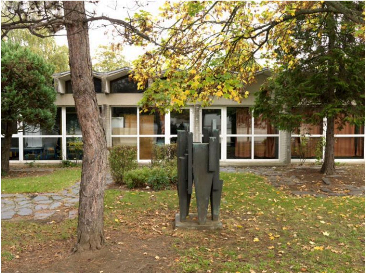
Le jardin au centre de l'école Rousseau. Au fond les deux salles de classe qui prennent le jour de ce côté.
