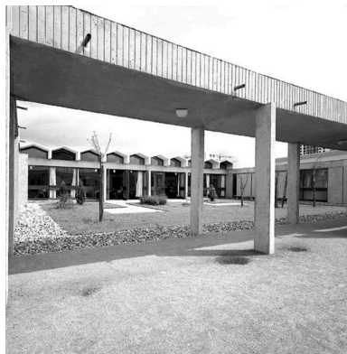
La galerie qui longe la cour. On aperçoit des classes avec leur vitrerie d'origine. (Fonds Bertin). Phot. Bertin IVR11_20177800594NUC2B
