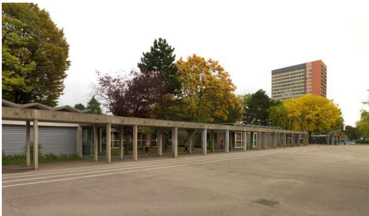
La cour de récréation prise vers l'est. On aperçoit la Tour Vega.
