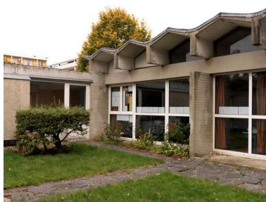
Baies d'une classe sur patio. Une baie fixe, une baie ouvrante.
