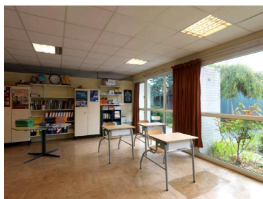
Vue d'une classe donnant sur un patio. L'adjonction du double-plafond empêche l'éclairage zénithal d'origine.
