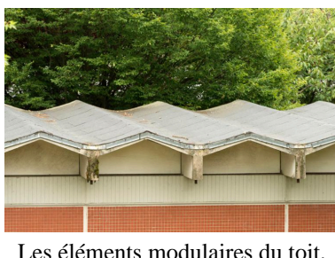
Les éléments modulaires du toit.
