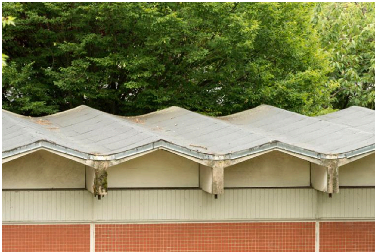
Les éléments modulaires du toit.
