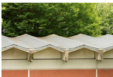
Les éléments modulaires du toit.
