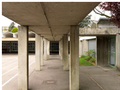
La galerie au niveau du deuxième couloir desservant l'école Rousseau. Phot. Laurent Kruszyk IVR11_20167800604NUC4A
