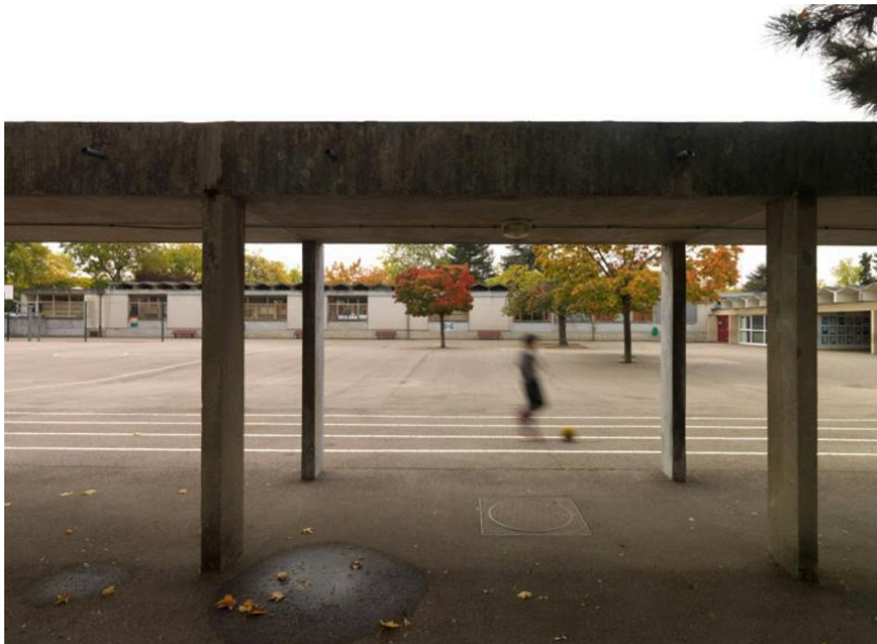
La cour vue du préau.
