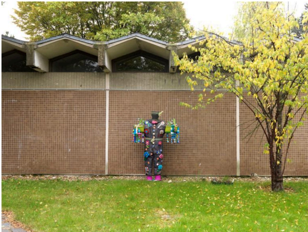
Façade nord des classes avec patio.
