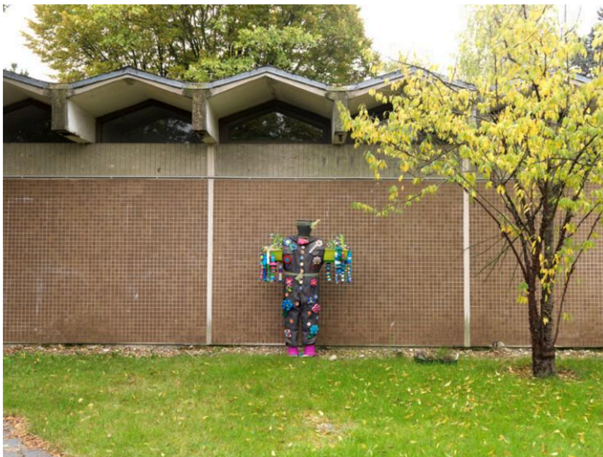
Façade nord des classes avec patio.
