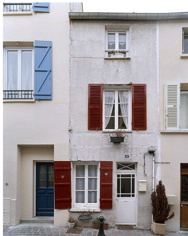
La façade sur rue. Phot. Laurent Kruszyk IVR11_20067800202VA
