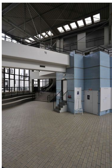
Vue d'ensemble du hall d'entrée de l'édifice. Phot. Philippe Ayrault IVR11_20129500300NUC4A
