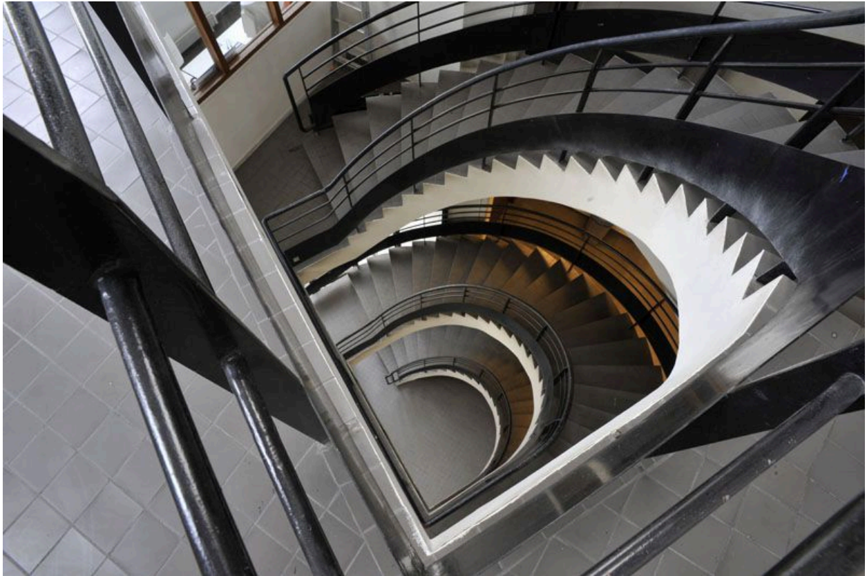
Vue d'ensemble de l'escalier.
