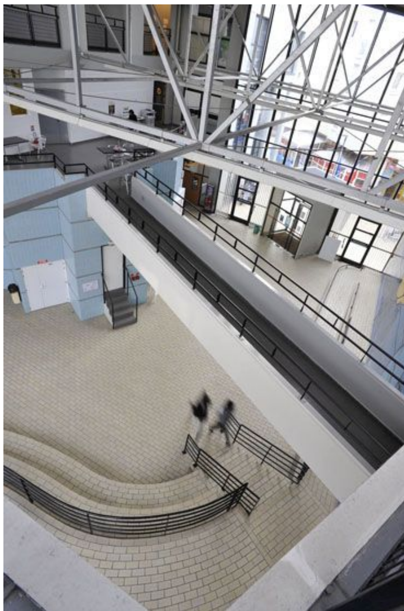
Vue d'ensemble du hall central depuis les coursives hautes.
