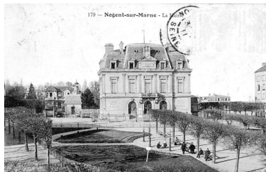
Façade antérieure. Carte postale. (AD Val-de-Marne) IVR11_19829400349XB
