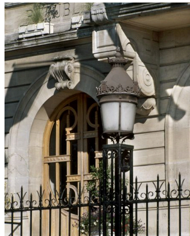
Détail d'une porte extérieure et d'une lanterne ornant la grille d'entrée.
