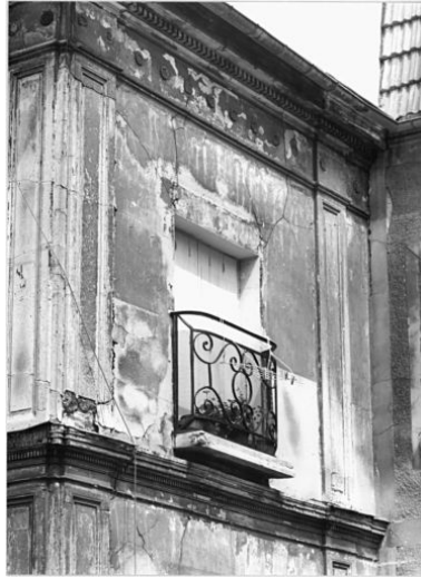
Détail de la facade postérieure du corps de logis : appui de fenêtre XVIIIe siècle et décor en plâtre 1ère moitié XIXè siècle. Phot. Christian Décamps IVR11_19859401204X
