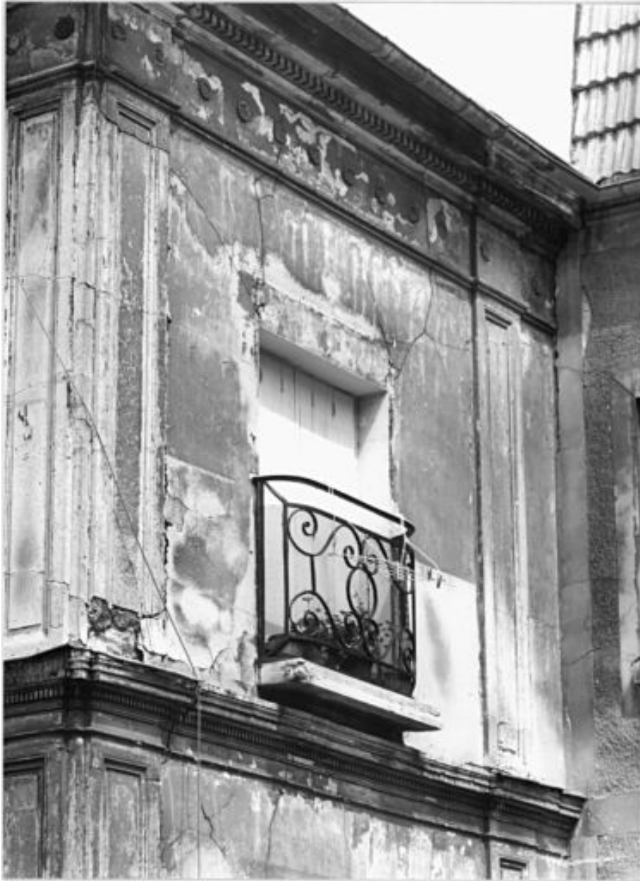
Détail de la facade postérieure du corps de logis : appui de fenêtre XVIIIe siècle et décor en plâtre 1ère moitié XIXè siècle.
