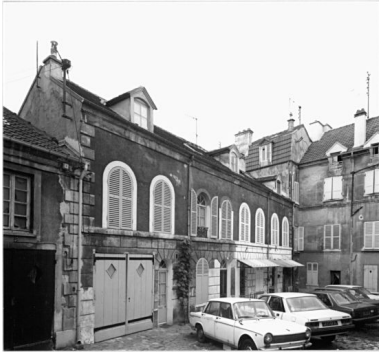
Ecuries, logement de domestiques et remises (à gauche) ; corps de logis (au fond). Phot. Christian Décamps IVR11_19859401203V
