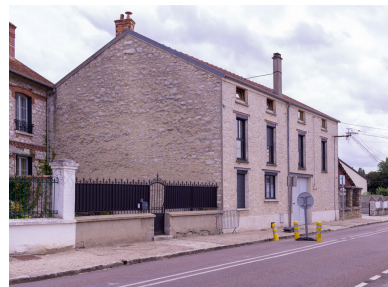
Vue générale de l'ancien séchoir à plantes depuis le nord-ouest. Phot. Asseline Stéphane IVR11_20259100903NUC4A
