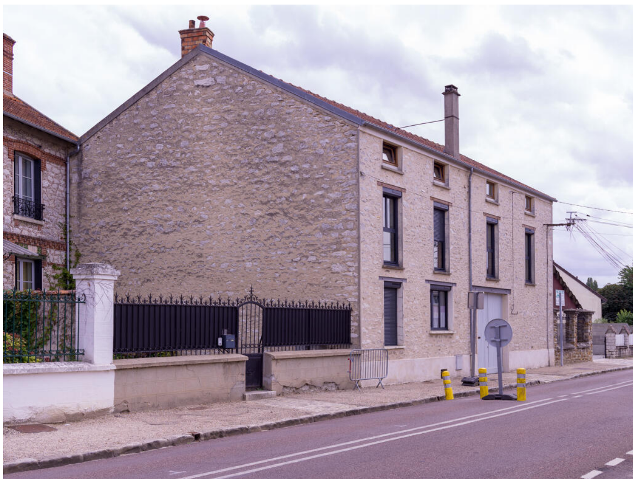
Vue générale de l'ancien séchoir à plantes depuis le nord-ouest.
