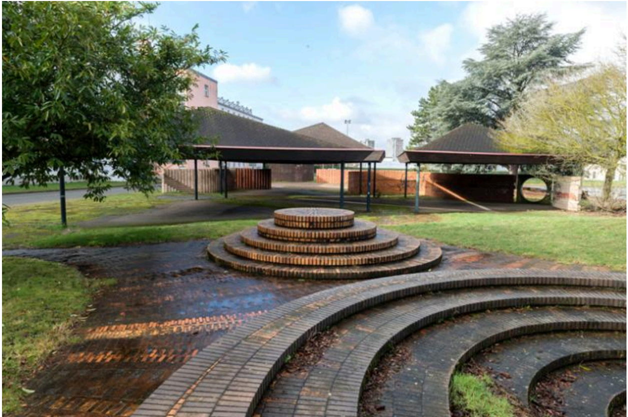
Détail des aménagements de Charles Gianferrari pour le patio séparant le lycée Saint-Exupéry du lycée Jean Rostand (1969) : gradins en briques de Vaugirard et dallage en briques et dalles de grès. Au fond, sous les préaux, les murs-écrans en briques de Vaugirard.
