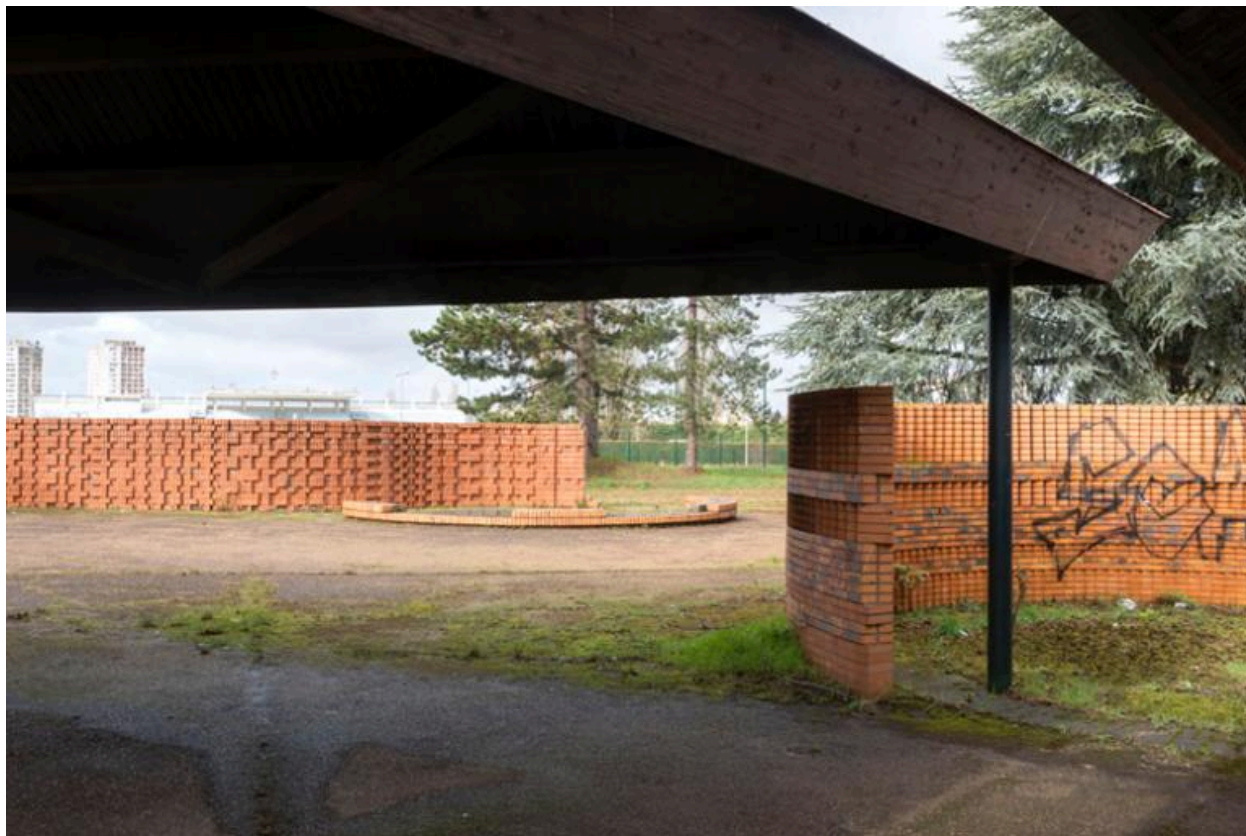
Détail des murs-écrans de forme sinueuse en briques de Vaugirard, réalisés par Charles Gianferrari pour le patio séparant le lycée Saint-Exupéry du lycée Jean Rostand. 1969)
