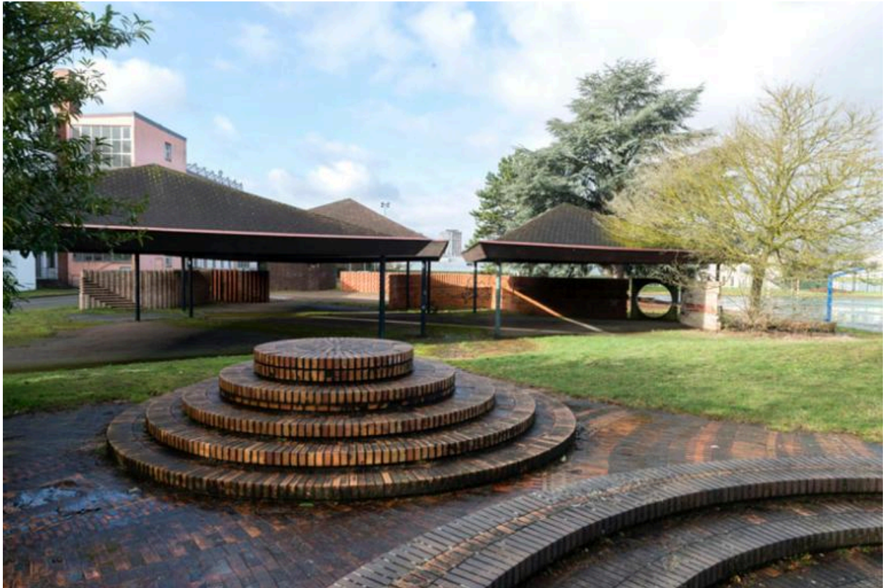
Détail des aménagements de Charles Gianferrari pour le patio séparant le lycée Saint-Exupéry du lycée Jean Rostand (1969) : gradins en briques de Vaugirard et dallage en briques et dalles de grès. Au fond, sous les préaux, les murs-écrans en briques de Vaugirard.
