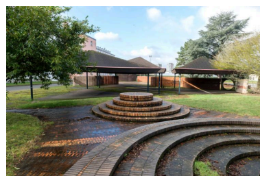
Détail des aménagements de Charles Gianferrari pour le patio séparant le lycée Saint-Exupéry du lycée Jean Rostand (1969) : gradins en briques de Vaugirard et dallage en briques et dalles de grès. Au fond, sous les préaux, les murs-écrans en briques de Vaugirard. Phot. Philippe Ayrault IVR11_20177800271NUC4A
