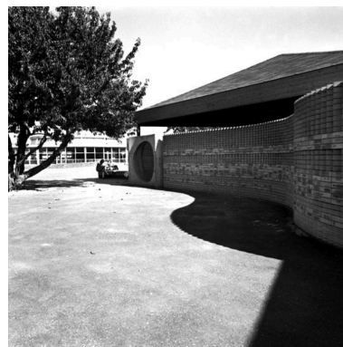
Vue du mur écran de Charles Gianferrari juste après sa réalisation. (Fonds Bertin) Phot. Bertin IVR11_20177800588NUC2B
