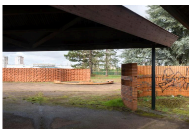
Détail des murs-écrans de forme sinuose en briques de Vaugirard, réalisés par Charles Gianferrari pour
