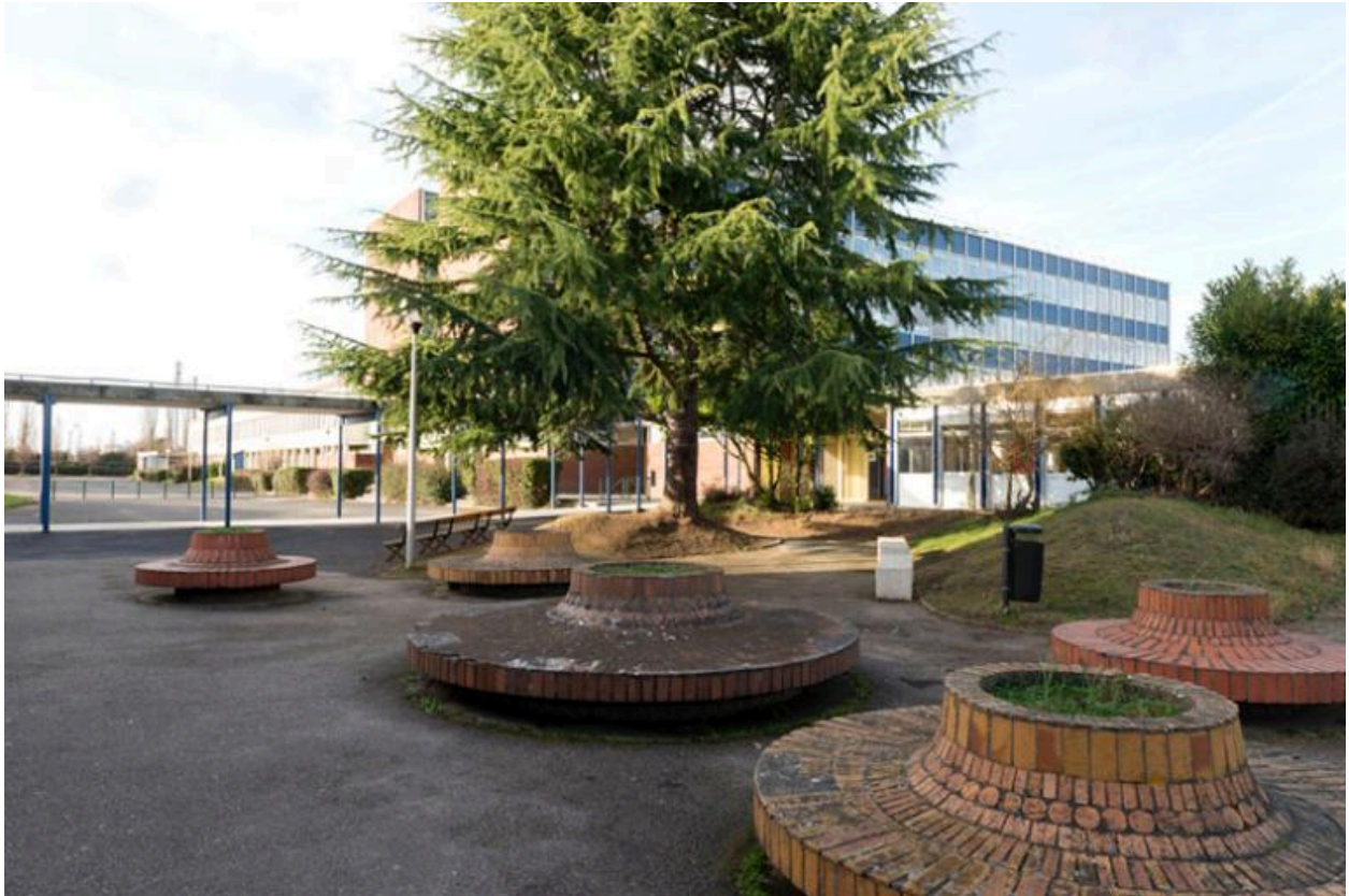
Détail des bancs-plates-formes circulaires en béton ornés de galets de pierre et de briques, conçus par Charles Gianferrari pour le jardin situé entre le lycée Jean Rostand et le réfectoire.
