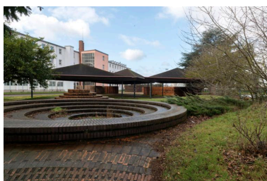
Aménagements du patio situé entre le lycée Saint-Exupéry et le lycée Jean Rostand : préaux, murs-écrans et gradins de Charles Gianferrari (1969). Phot. Philippe Ayrault IVR11_20177800270NUC4A
