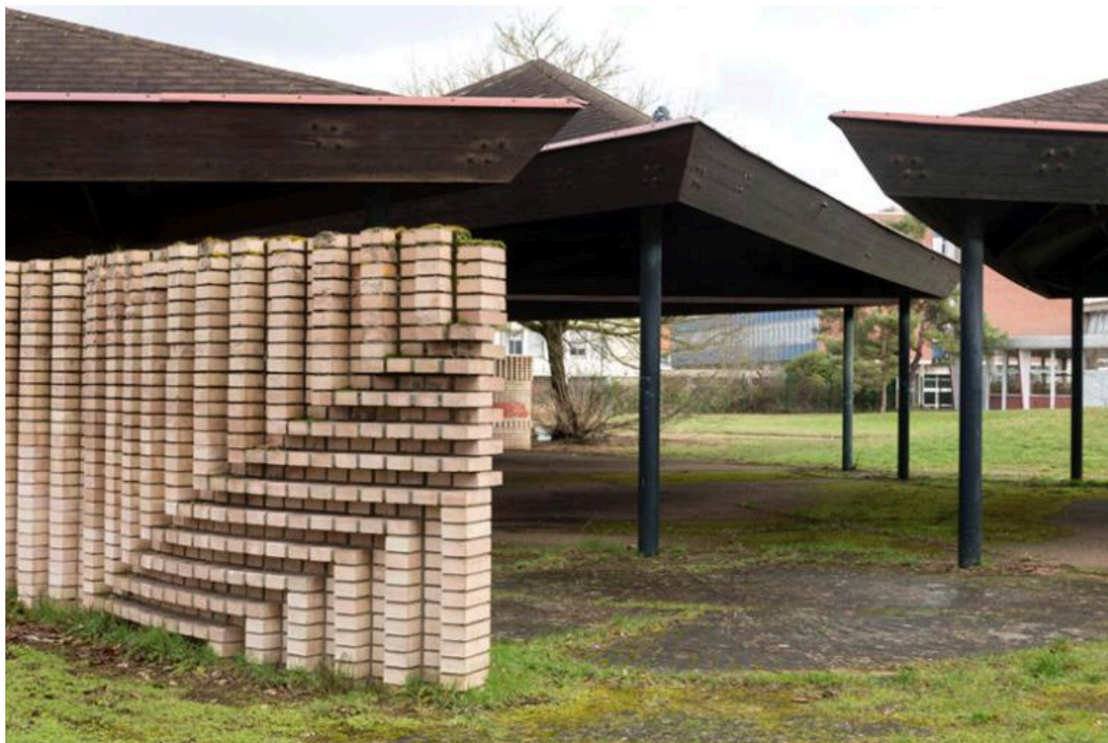
Détail du travail de calepinage d'un mur-écran en briques de Vaugirard, réalisé par Charles Gianferrari (1969).
