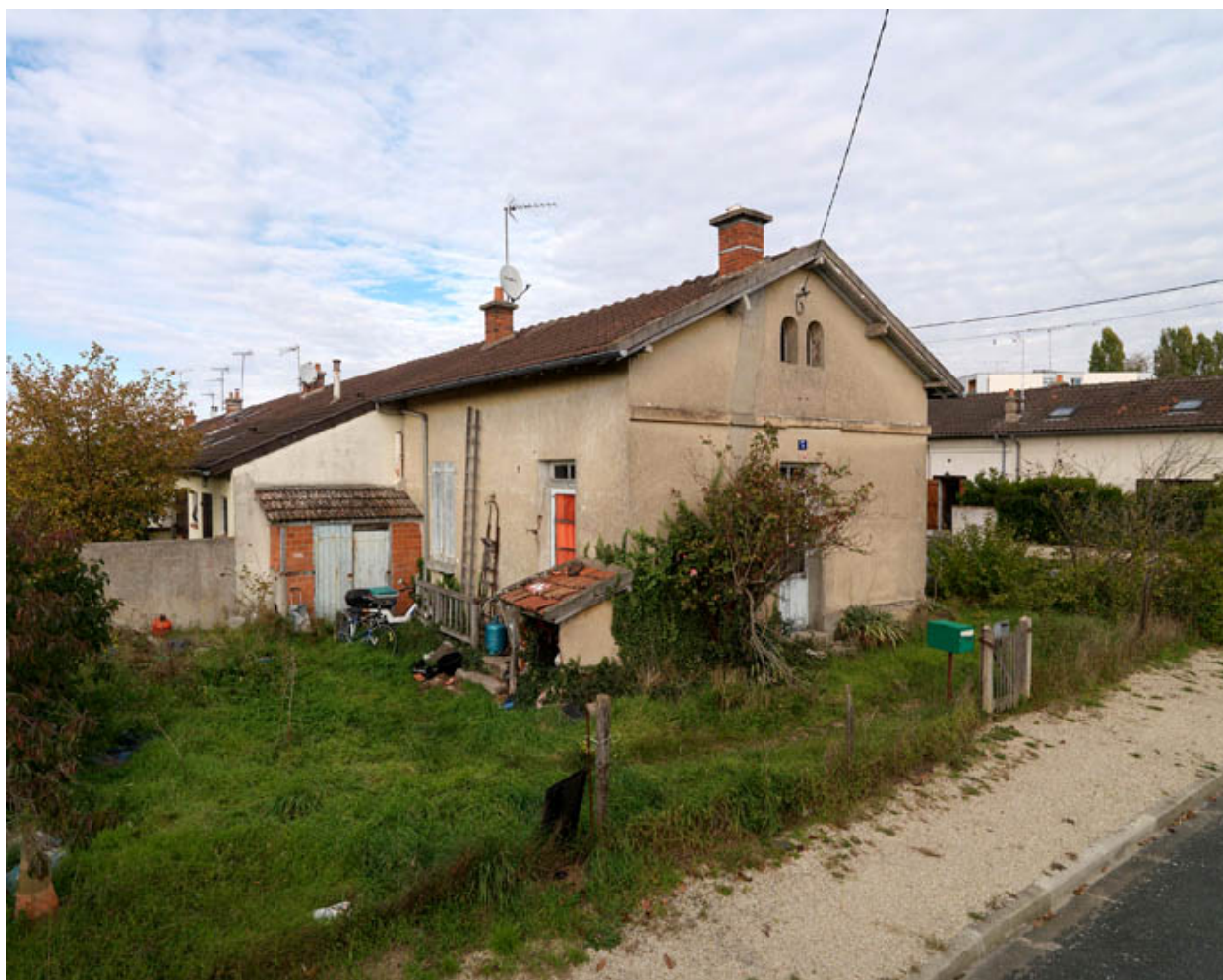
Vue d'une maison et de son jardin;
