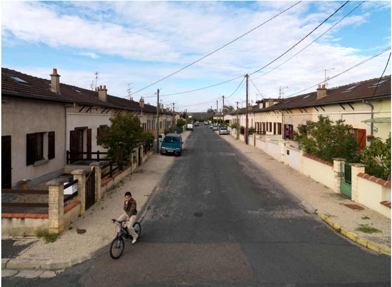
Les rangs de l'Aubépine. Logements en bande qui offrent 96 appartements de 3 pièces.
