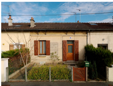
Les rangs de l'Aubépine 24 rue Achille Fournier.. Logements en bande qui offrent 96 appartements de 3 pièces. Phot. Philippe Ayrault IVR11_20117700586NUC4A
