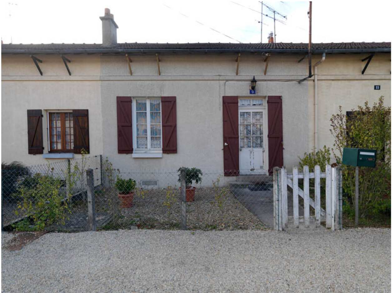
Les rangs de l'Aubépine. Logements en bande qui offrent 96 appartements de 3 pièces.
