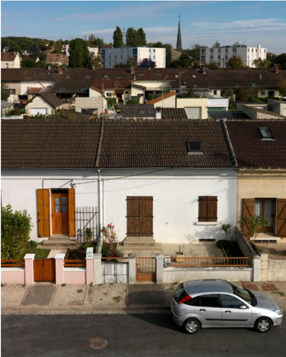
Les rangs de l'Aubépine. Logements en bande qui offrent 96 appartements de 3 pièces.
