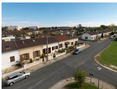
Les rangs de l'Aubépine, rue Henri Paul. Logements en bande qui offrent 96 appartements de 3 pièces. Phot. Philippe Ayrault IVR11_20117700580NUC4A
