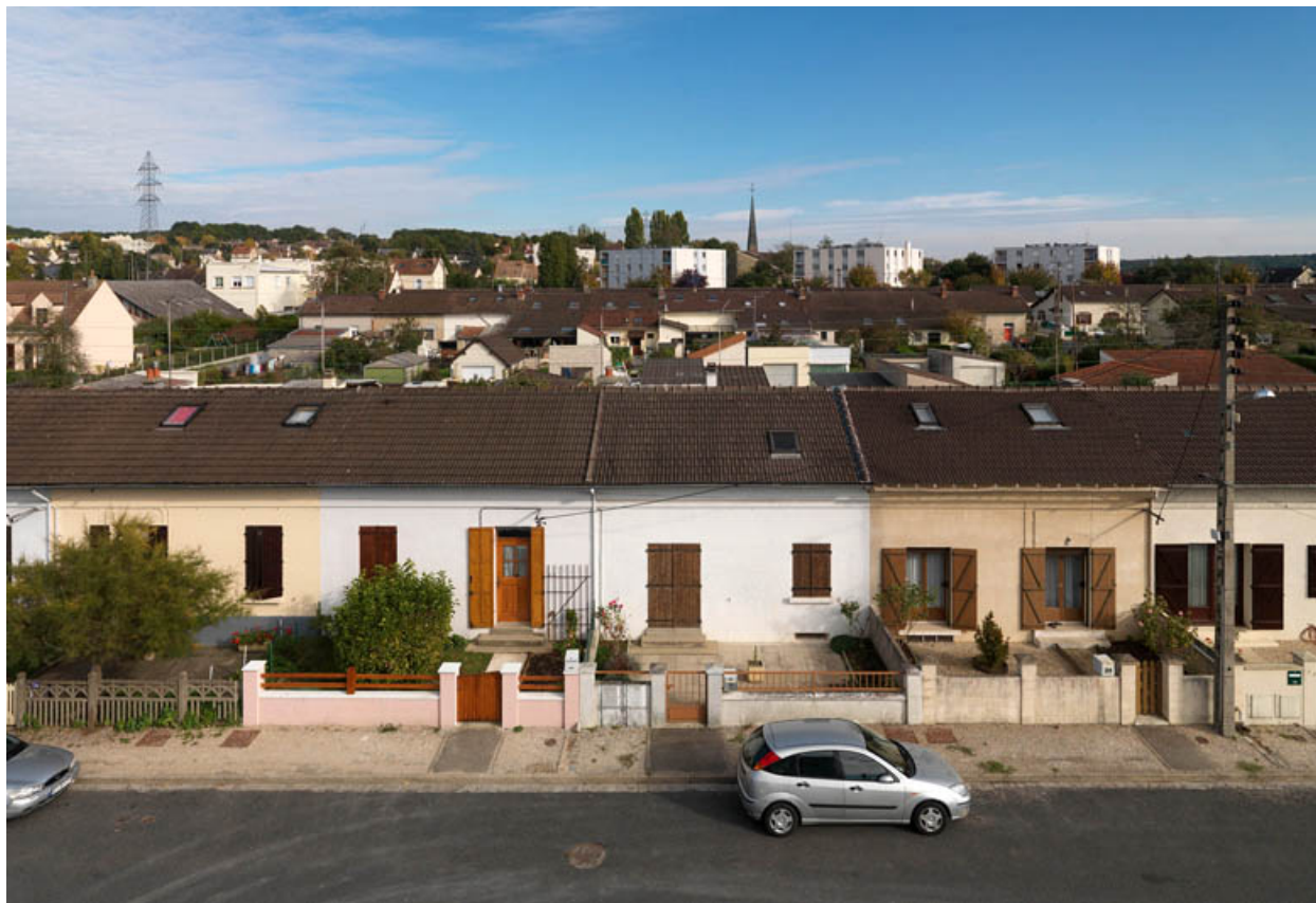
Les rangs de l'Aubépine. Logements en bande qui offrent 96 appartements de 3 pièces.
