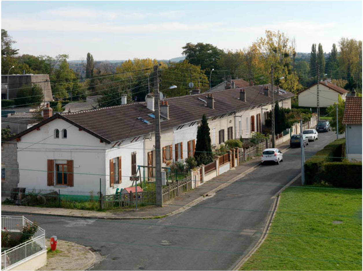
Les rangs de l'Aubépine. logements en bande qui offrent 96 appartements de 3 pièces.
