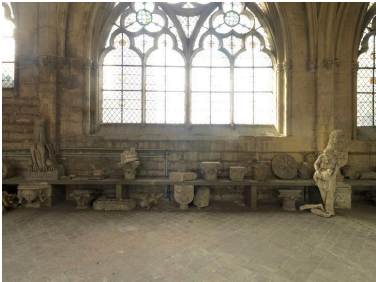
Deuxième partie du dépôt conservé dans les tribunes sud. Une gargouille à gauche et une statue de berger en plâtre en très mauvais état à droite.
