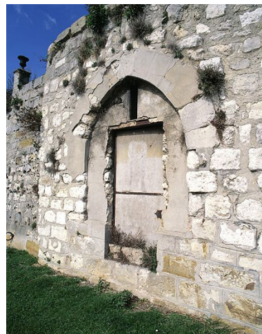
Vestiges des fortifications, sur la rive sud de l'île Saint- Etienne : détail d'une poterne. Phot. Stéphane Asseline IVR11_20047700419XA
