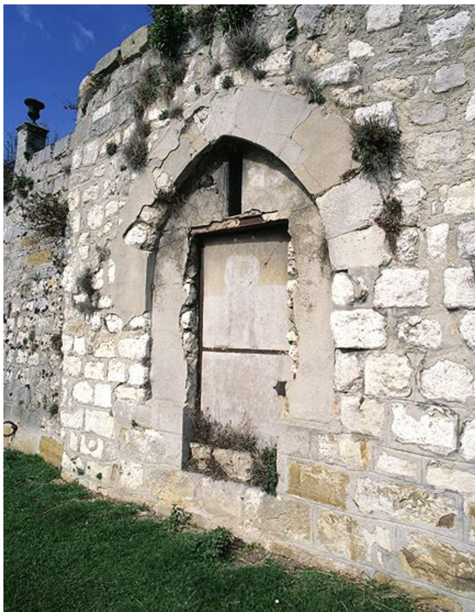
Vestiges des fortifications, sur la rive sud de l'île Saint-Etienne : détail d'une poterne.
