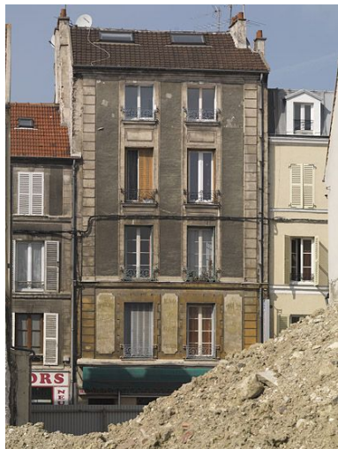
Vue d'ensemble, depuis le cours Raoult. Phot. Stéphane Asseline IVR11_20097700302NUC4A
