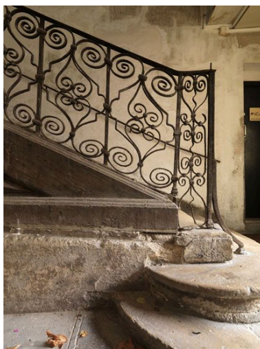
Vue du départ de l'escalier. Phot. Laurent Kruszyk IVR11_20097501679NUC4A
