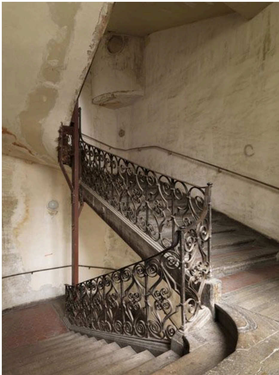
Vue d'ensemble des deuxième et troisième volées de l'escalier.
