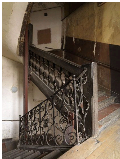
Vue de la transition entre garde- corps en fer forgé et balustres de bois. Phot. Laurent Kruszyk IVR11_20097501682NUC4A
