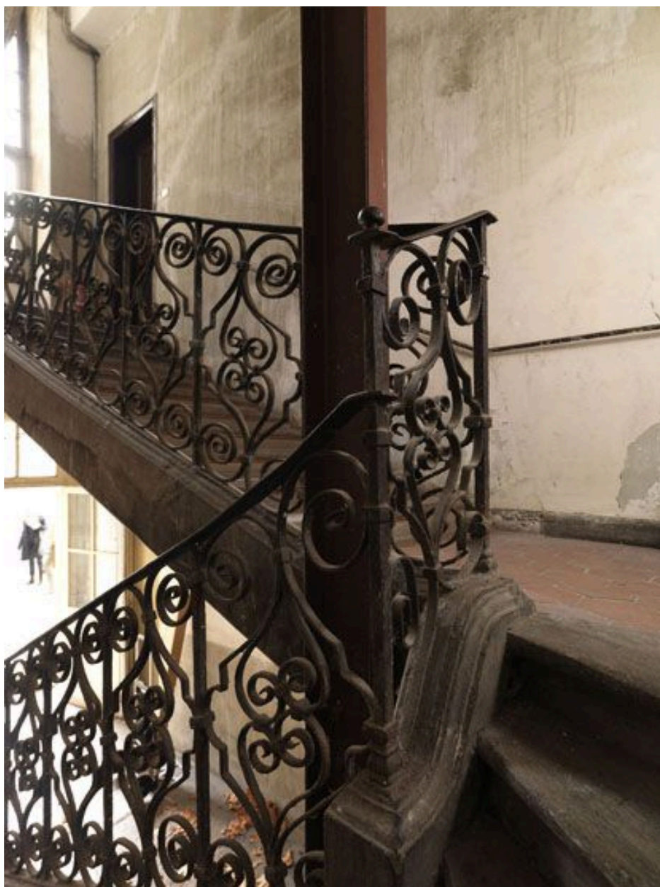
Vue d'ensemble de la deuxième volée de l'escalier.
