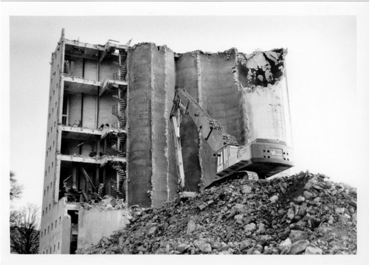
Les silos en cours de démolition. 5 janvier 1999. (Collection particulière)
