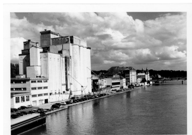
Vue générale de l'île Saint-Etienne, avec les silos et les Moulins de Melun, depuis le sud-ouest. 15 septembre 1995. (Collection particulière) Phot. Philippe Ayrault, Autr. Claude Descloux IVR11_20057700328NUCB
