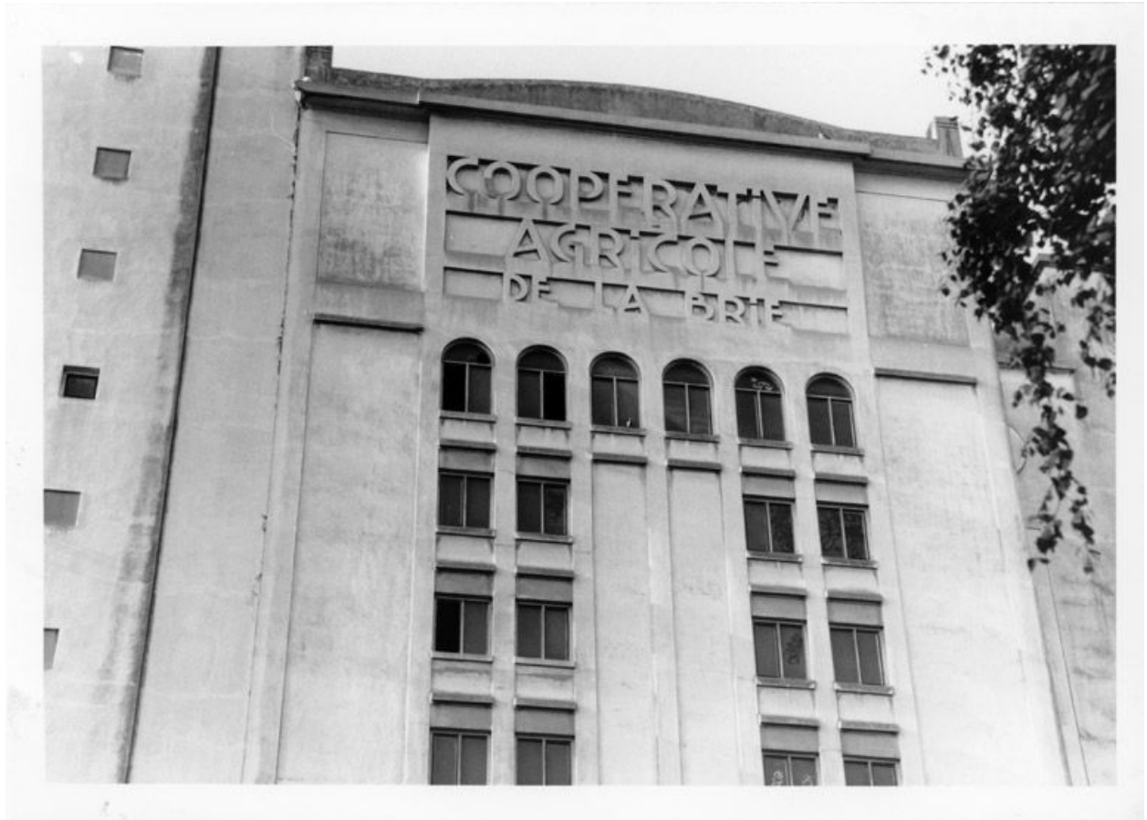
Détail de la façade, sur la rue du Château. 30 septembre 1998. (Collection particulière)
