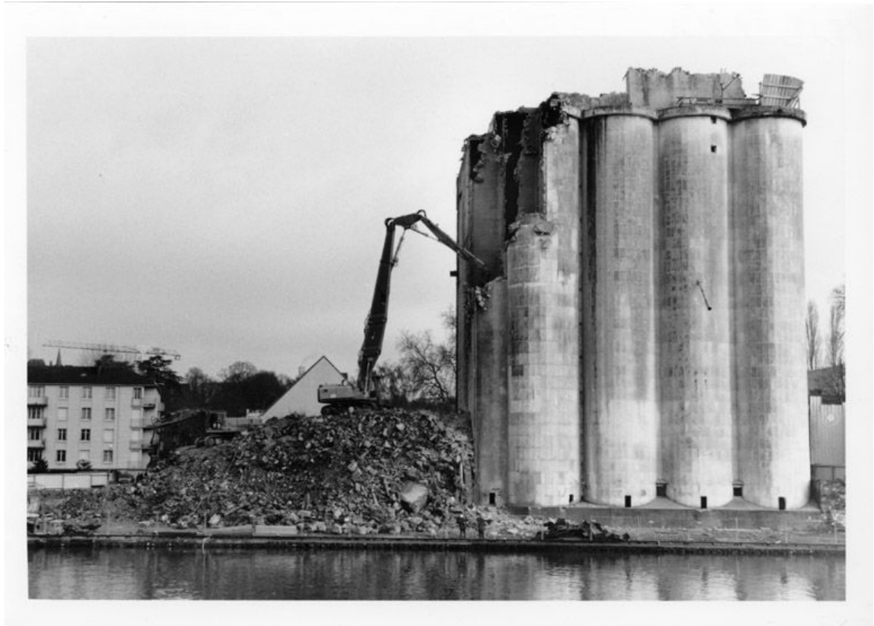
Les silos en cours de démolition. 15 décembre 1998. (Collection particulière)
