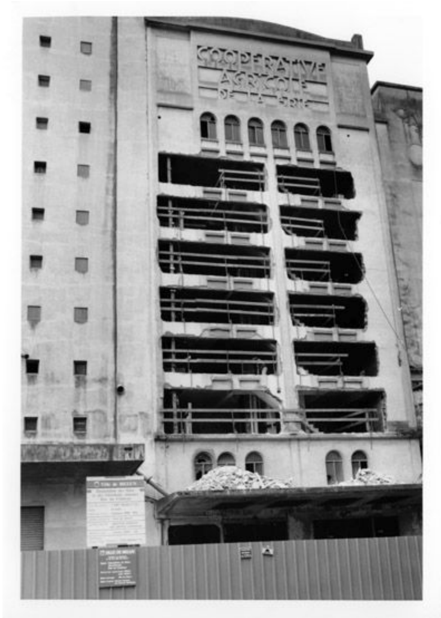
La façade des silos en cours de démolition. 1er novembre 1998. (Collection particulière)
