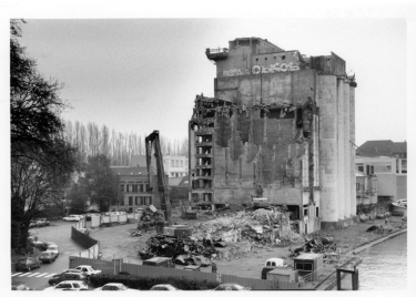
Les silos en cours de démolition. 30 novembre 1998. (Collection particulière) Phot. Philippe Ayrault, Autr. Claude Descloux IVR11_20057700333NUCB
