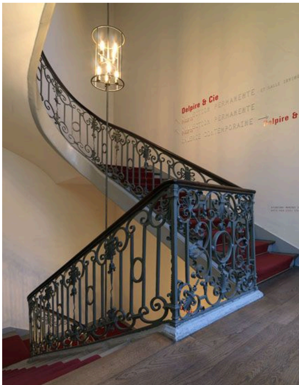
Vue d'ensemble du palier du premier étage et de la troisième volée.
