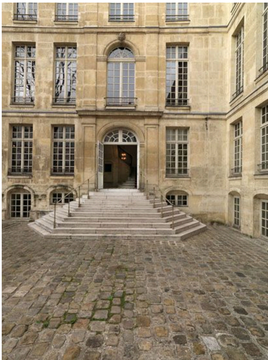
Vue de la cour et de la porte ouvrant sur l'escalier.
