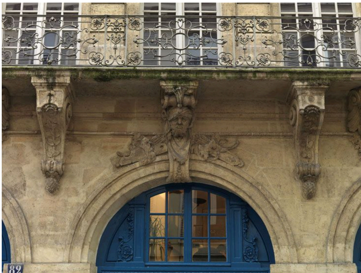
Détail des consoles du balcon.
