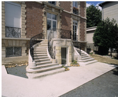
Vue de l'escalier en U situé sur la façade arrière. Phot. Philippe Ayrault IVR11_20029100785XA
