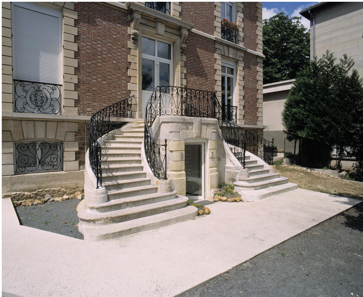
Vue de l'escalier en U situé sur la façade arrière.
