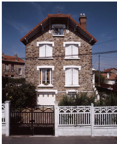
Vue d'ensemble. Phot. Philippe Ayrault IVR11_20049100518XA
