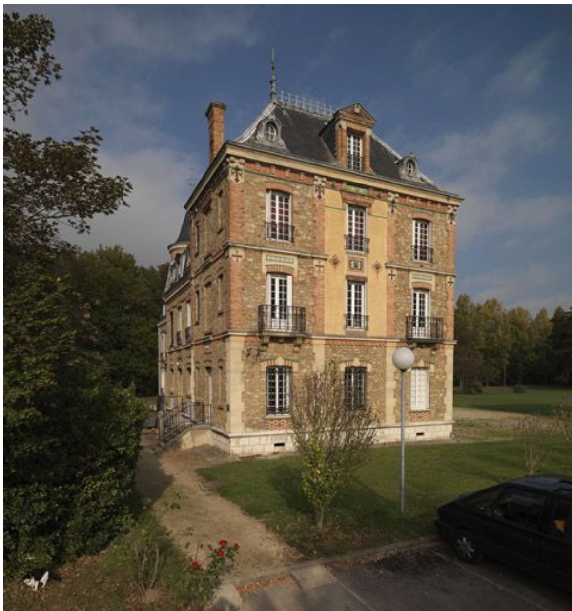
Vue de la façade latérale sud.
