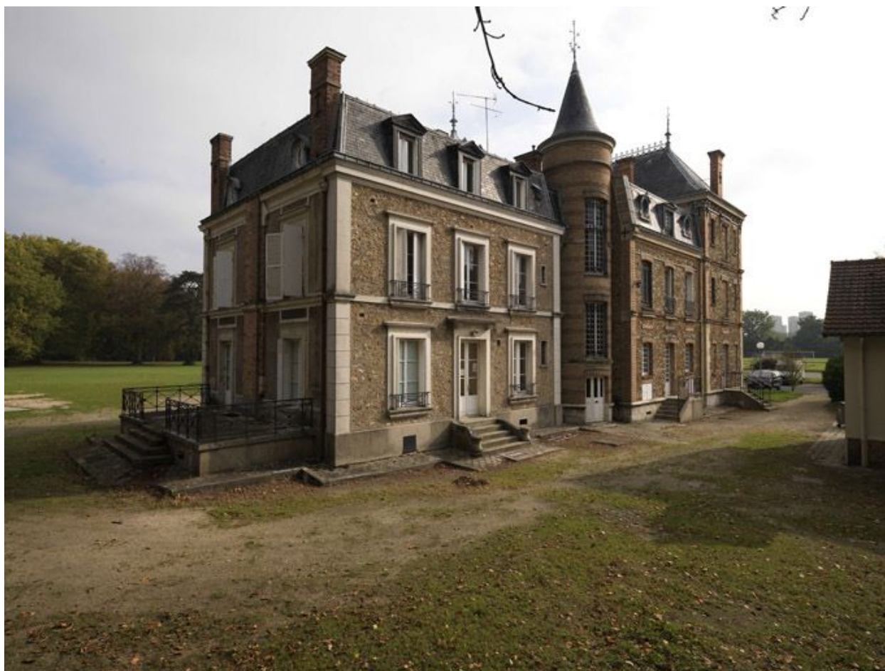
Vue d'ensemble, côté sud-ouest.
