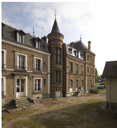
Vue de la façade sud-ouest. Phot. Philippe Ayrault IVR11_20089100111NUC4A
