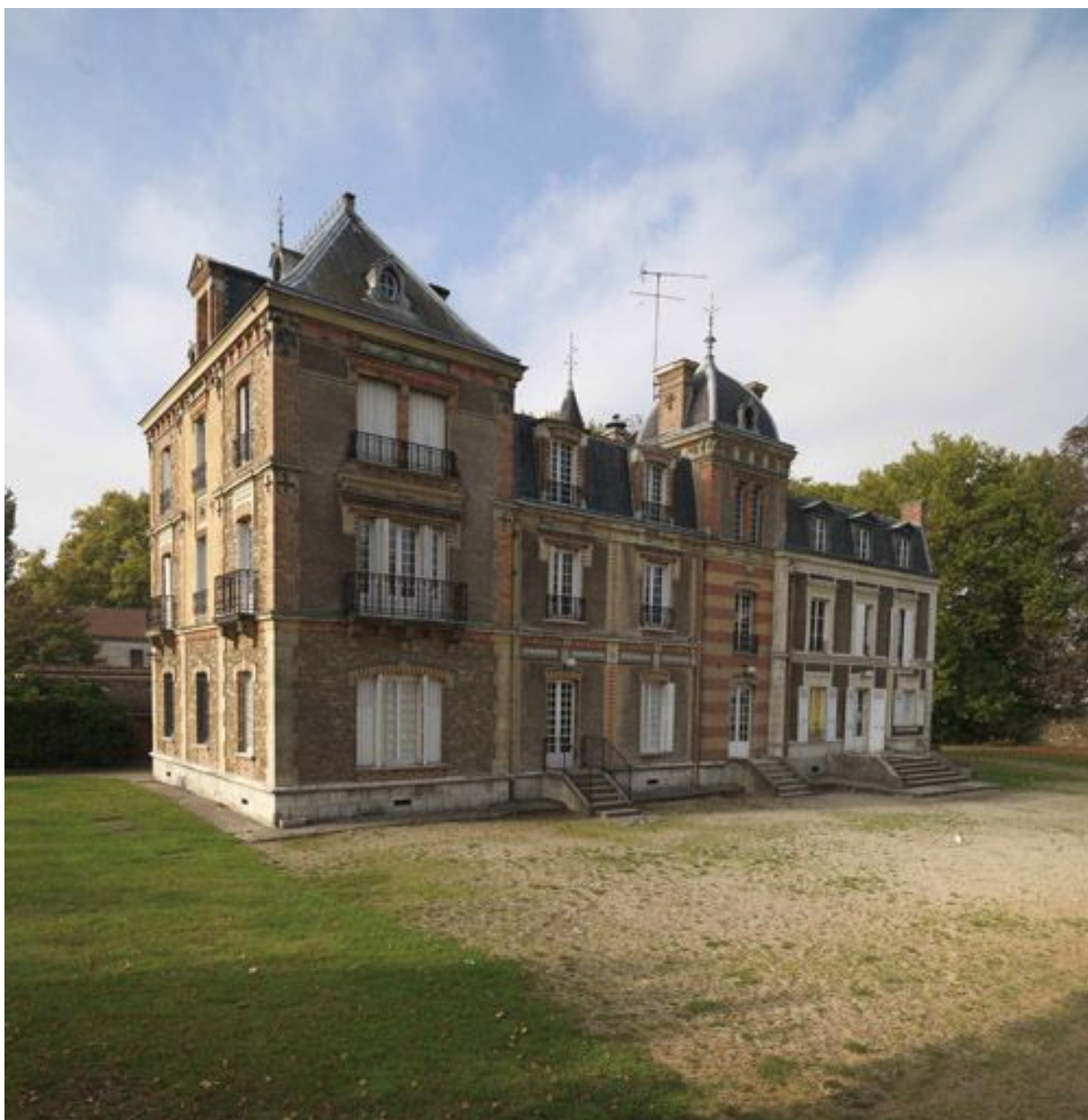
Vue de la façade nord-est.
