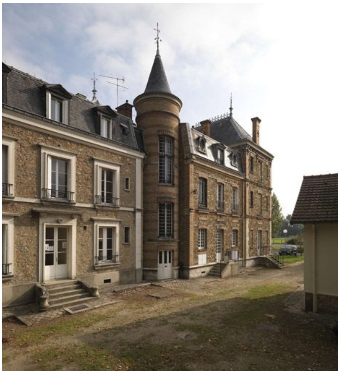
Vue de la façade sud-ouest.
