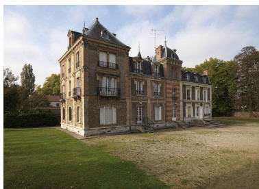
Vue d'ensemble. Phot. Philippe Ayrault IVR11_20089100107NUC4A
