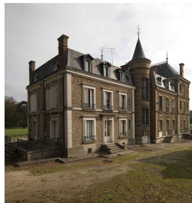
Autre vue d'ensemble, côté sud-ouest. Phot. Philippe Ayrault IVR11_20089100113NUC4A
