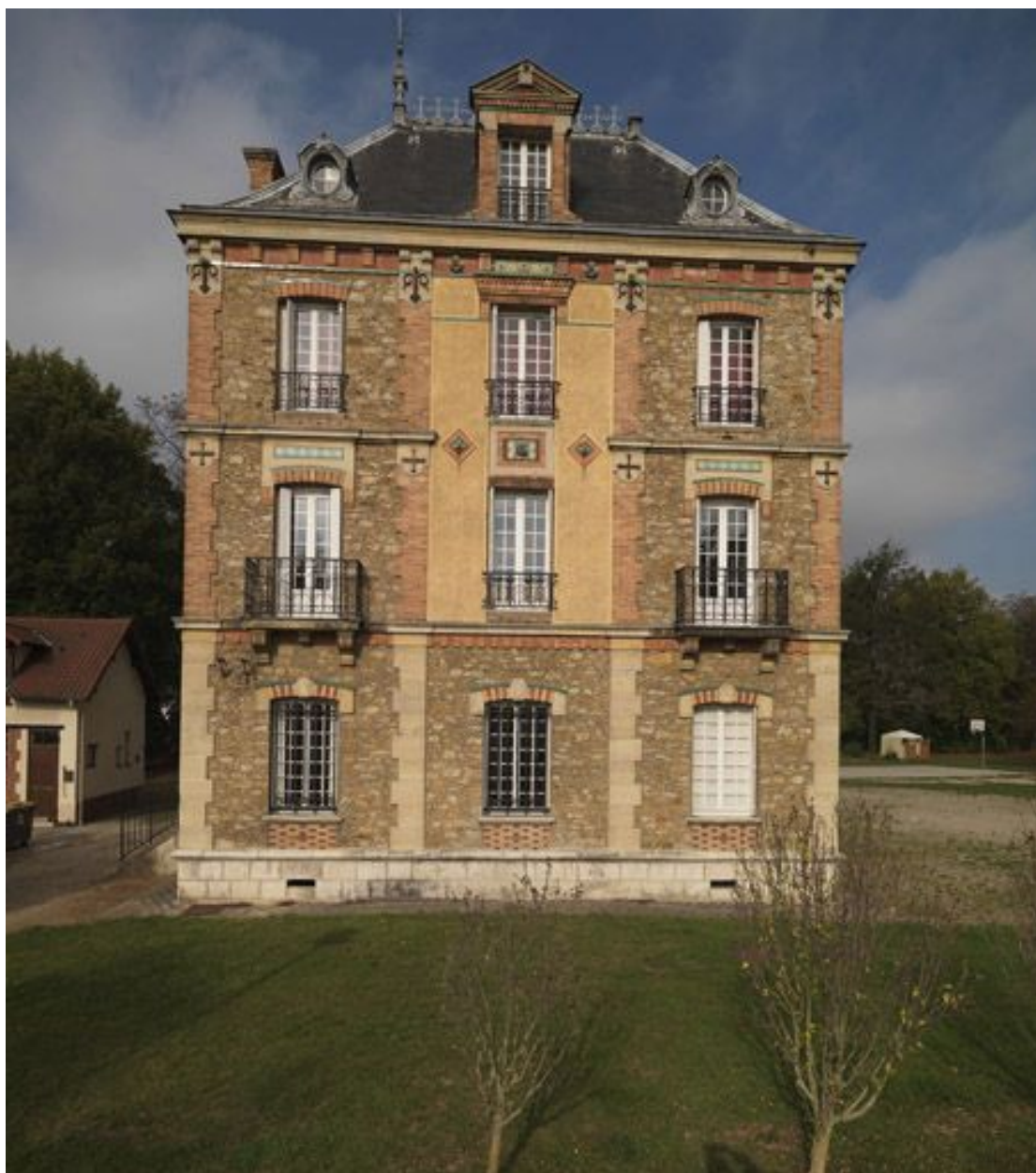
Vue frontale de la façade latérale sud.
