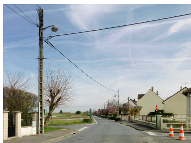
Asnières-sur-Oise. Zone pavillonnaire longeant un champ cultivé. Phot. Philippe Ayrault IVR11_20149500088NUC4A
