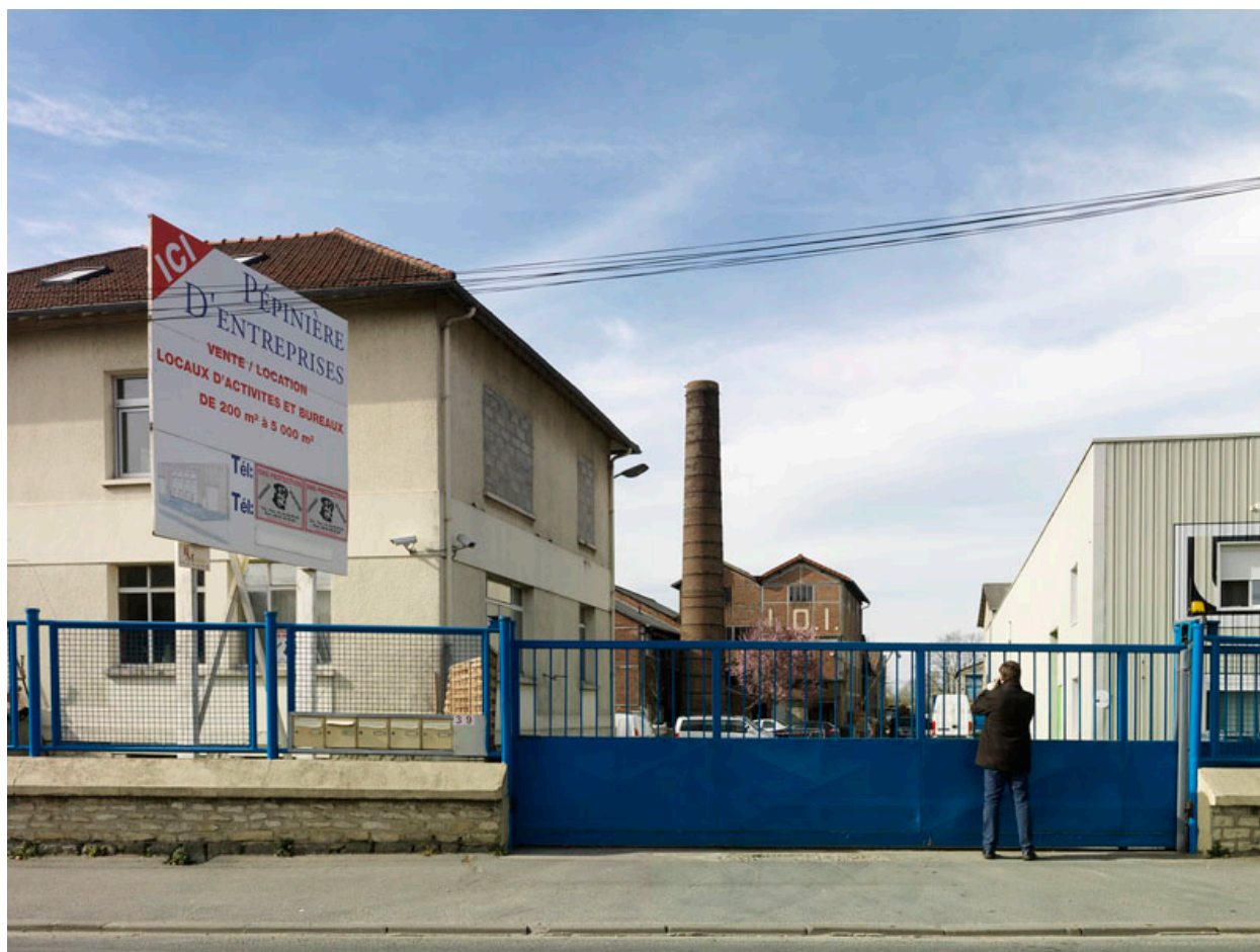
Persan. Le quai de l'industrie. Cheminée de l'usine de La Ouate Industrielle, actuellement pépinière d'entreprise. Élément de phrase urbaine.
