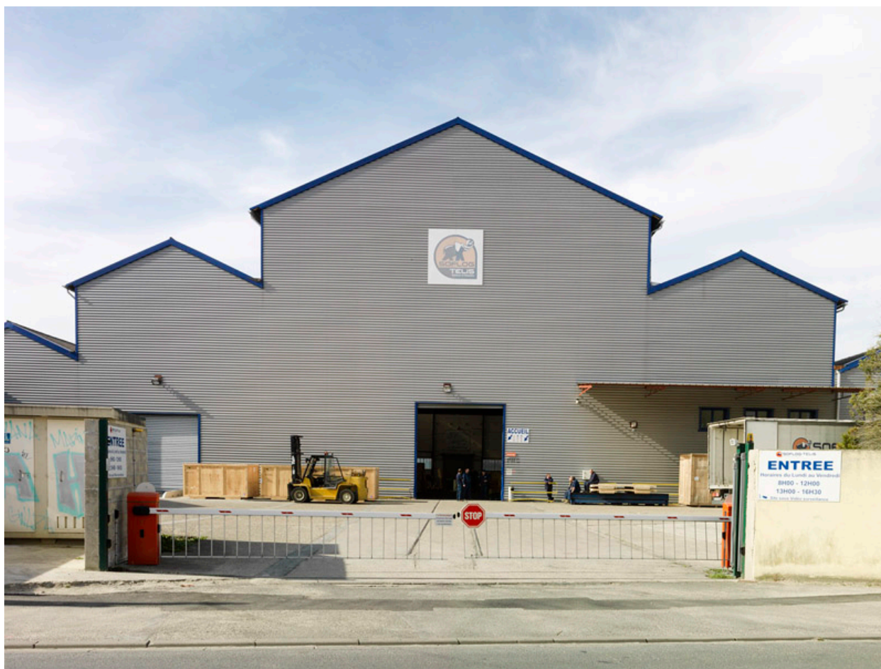
Persan. Le quai de l'industrie. Pignon en bardage d'un bâtiment industriel. Élément de phrase urbaine.
