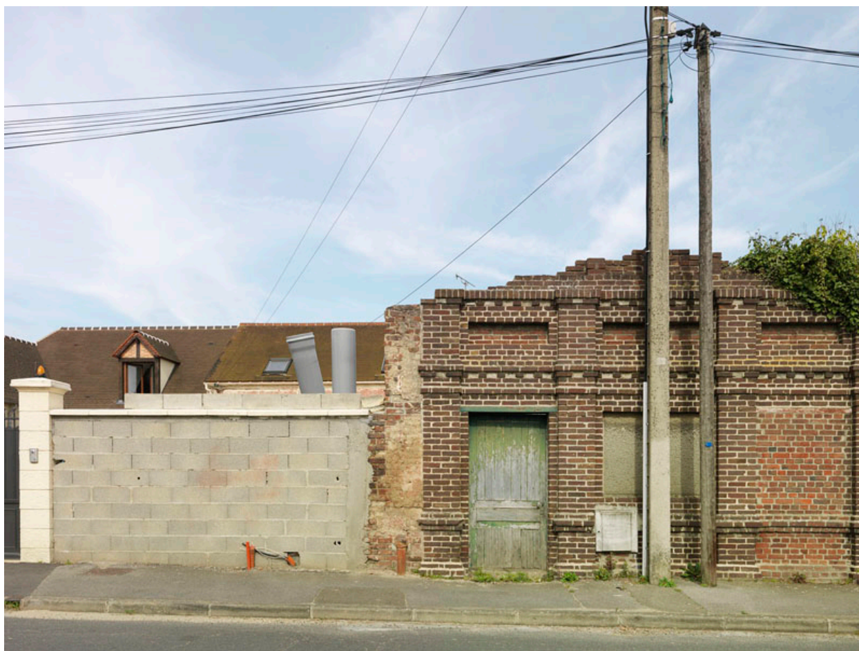
Asnières-sur-Oise. Mur récent en parpaings cotoyant le mur d'enceinte en briques rouges de l'ancienne usine Delacoste puis Vulli.
