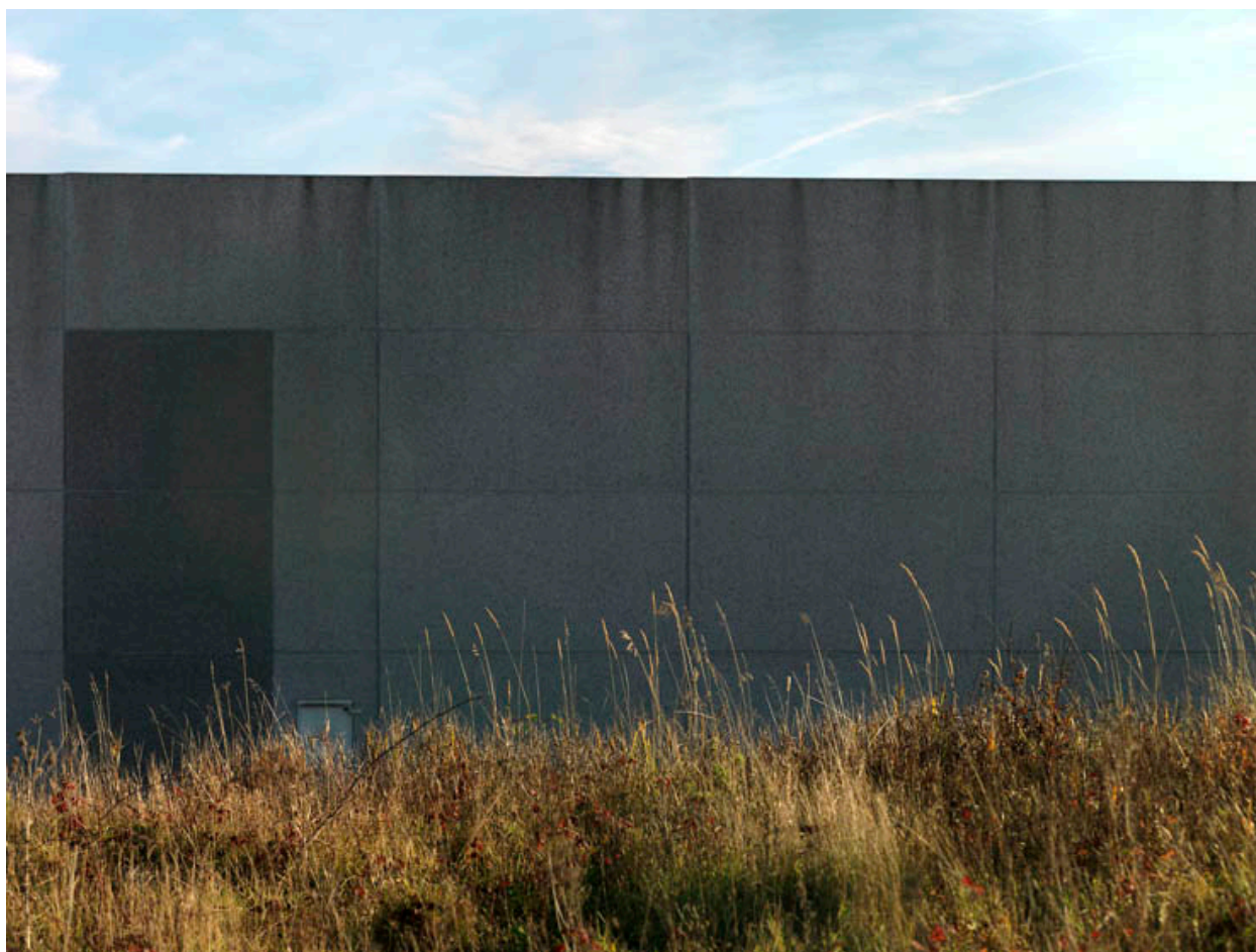
Surveilliers. ZI de la Porte des Champs. Entrepôt logistique. Bardage.
