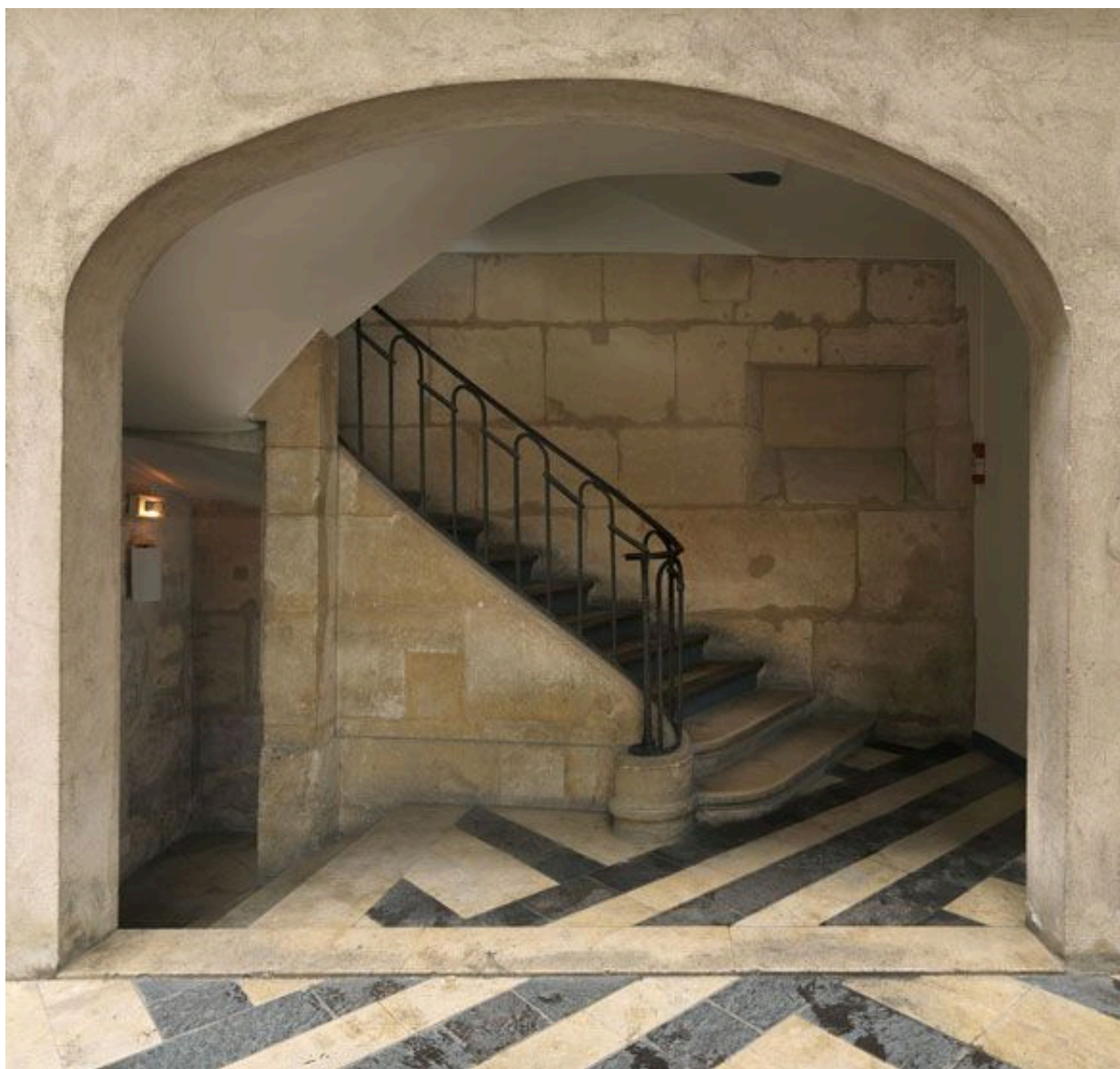
Départ ouvert de l'escalier.
