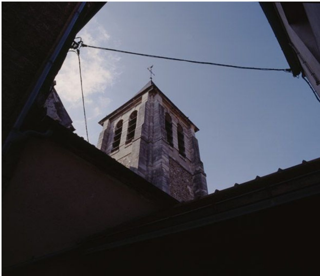
La partie haute du clocher.
