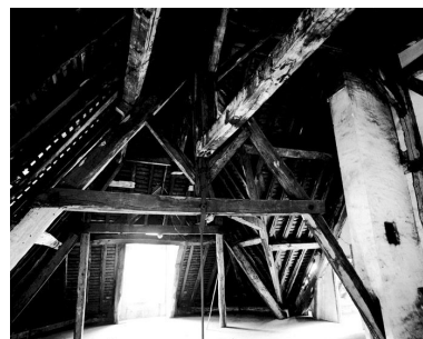
Vue de la charpente, dans l'angle nord-ouest de l'hôtel de ville. Phot. Stéphane Asseline IVR11_20037700587X
