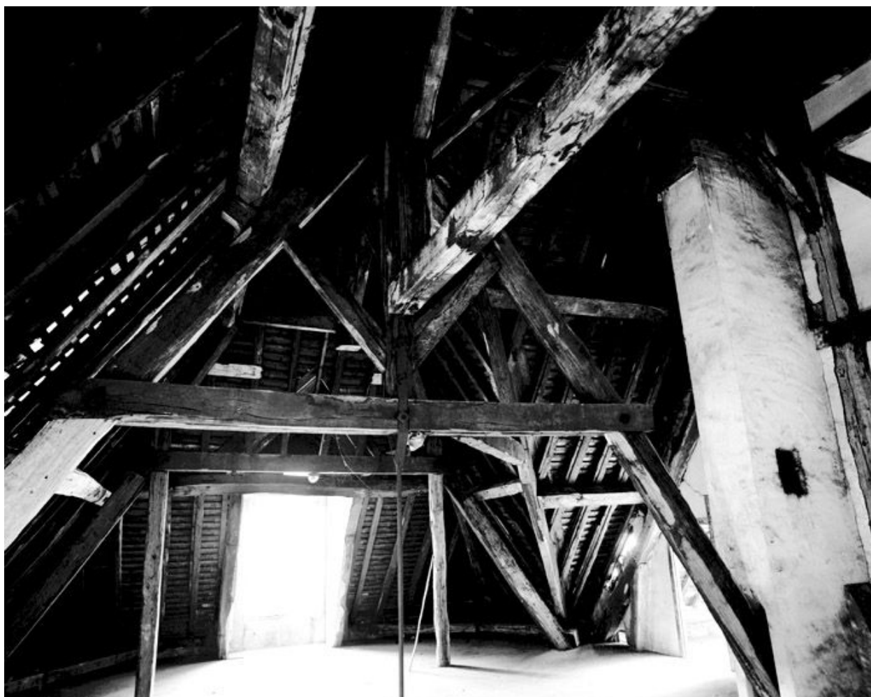
Vue de la charpente, dans l'angle nord-ouest de l'hôtel de ville.
