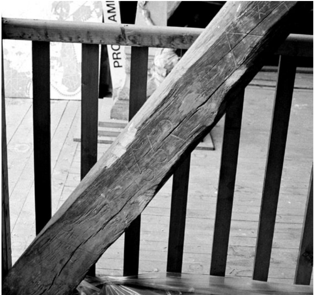
Charpente du corps central, détail : poutre avec inscription "'155...'".
