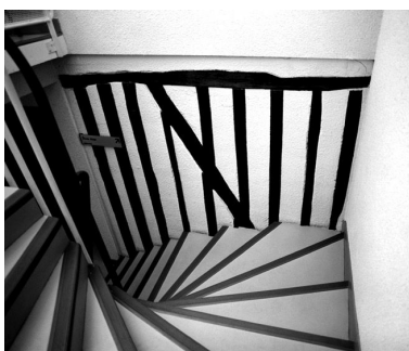
Structure en pan de bois, dans les locaux des services techniques de la Ville. Phot. Stéphane Asseline IVR11_20037700623X
