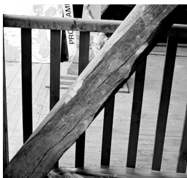
Charpente du corps central, détail : poutre avec inscription "155...". Phot. Stéphane Asseline IVR11_20037700590X
