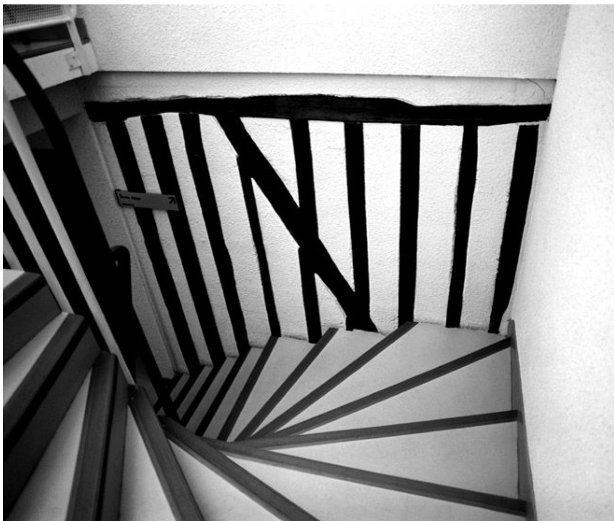
Structure en pan de bois, dans les locaux des services techniques de la Ville.
