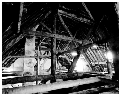
Charpente du corps central : vue d'ensemble. Phot. Stéphane Asseline IVR11_20037700589X
