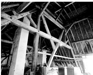
Charpente du corps central, vue depuis l'est. Phot. Stéphane Asseline IVR11_20037700588X
