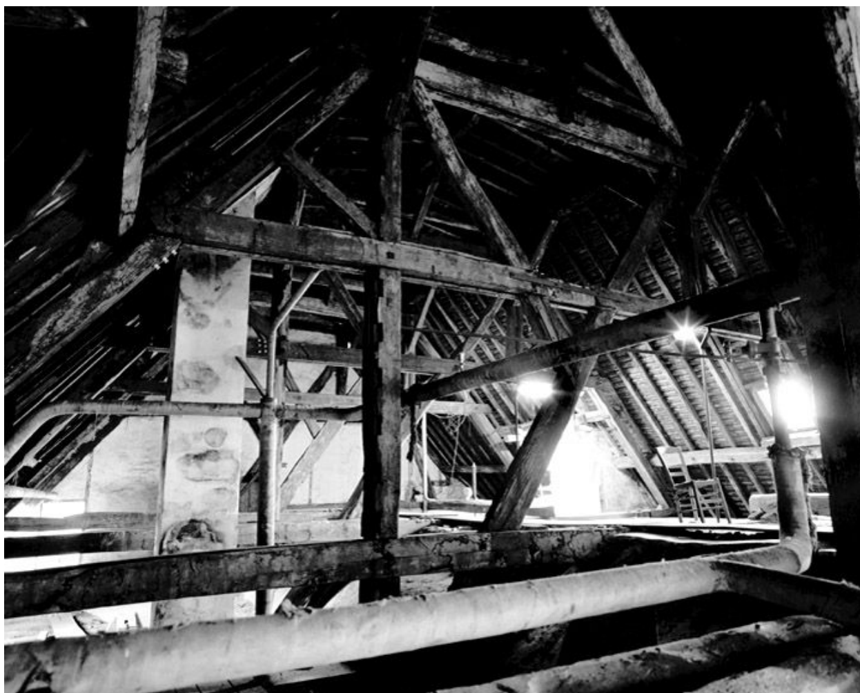
Charpente du corps central : vue d'ensemble.
