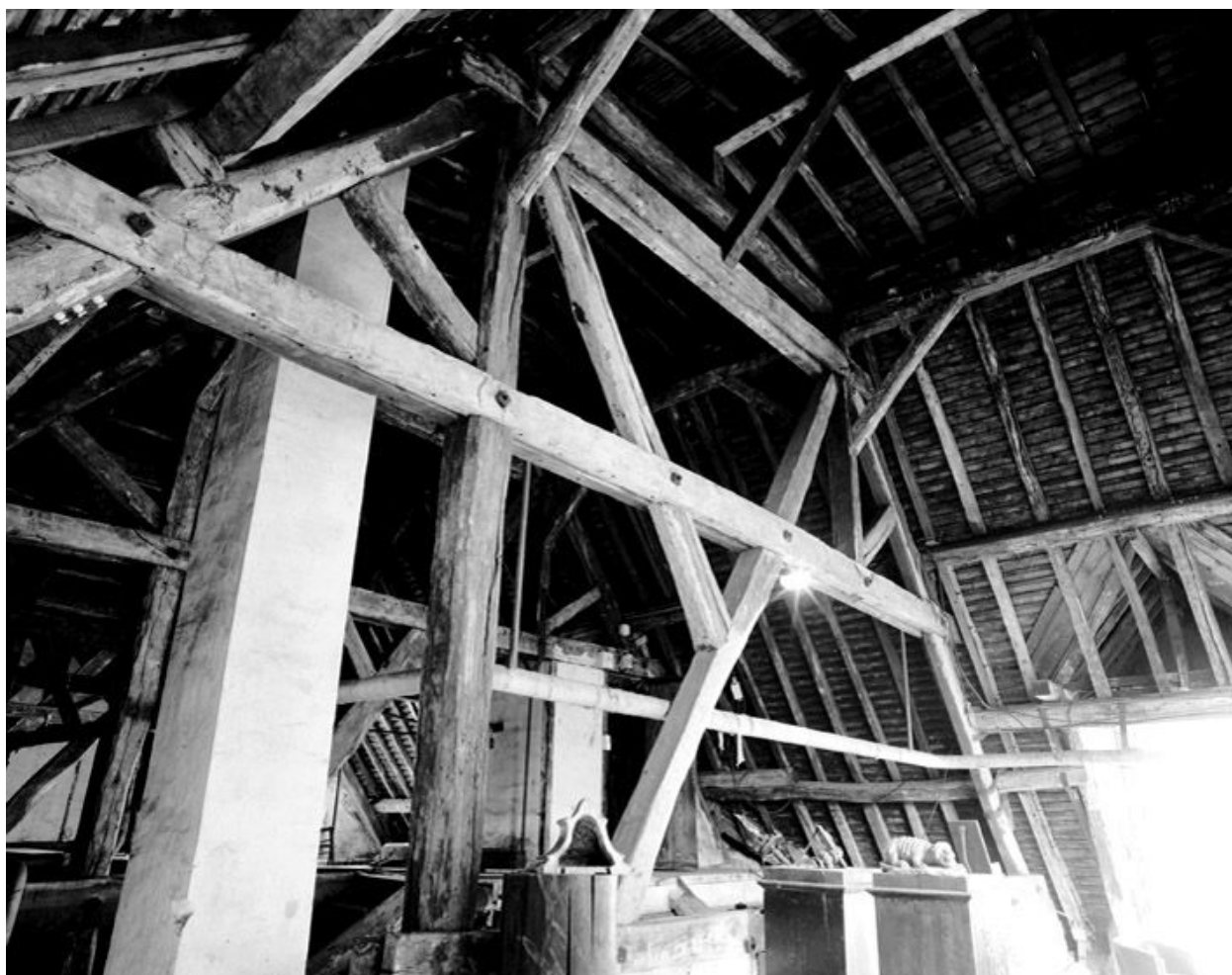
Charpente du corps central, vue depuis l'est.
