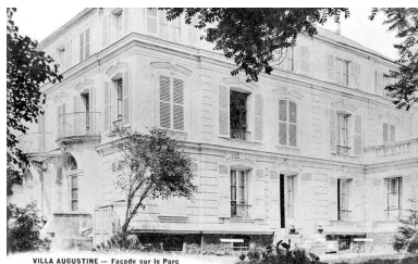
Façade postérieure de la villa Augustine. Carte postale. (AD Val-de-Marne) IVR11_19859400232XB
