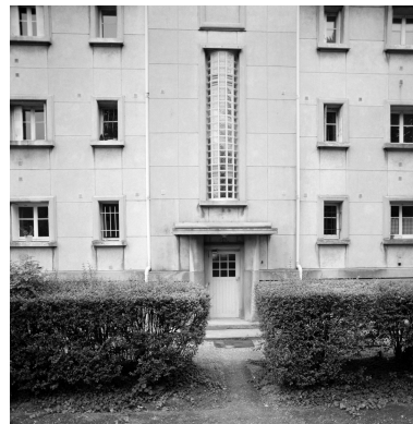
Façade postérieure de l'immeuble n° 5-7 : détail de la travée d'escalier et de sa fenêtre en pavés de verre. Phot. Philippe Ayrault IVR11_20029101258X
