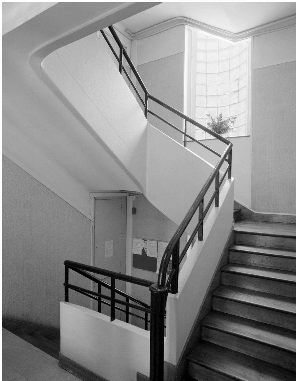
Une des cages d'escalier (n° 1).
