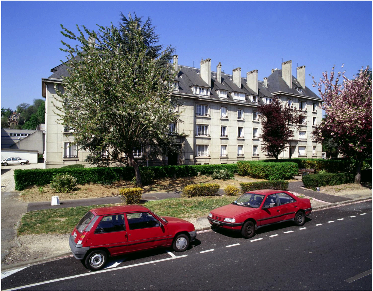
Vue d'ensemble de l'immeuble situé aux n° 1-3 de l'avenue.
