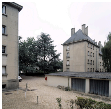
Les deux immeubles séparés à l'arrière par le bâtiment des garages. Phot. Philippe Ayrault IVR11_20029101253XA
