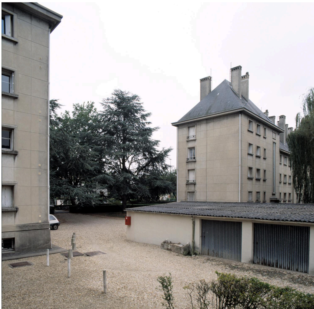
Les deux immeubles séparés à l'arrière par le bâtiment des garages.
