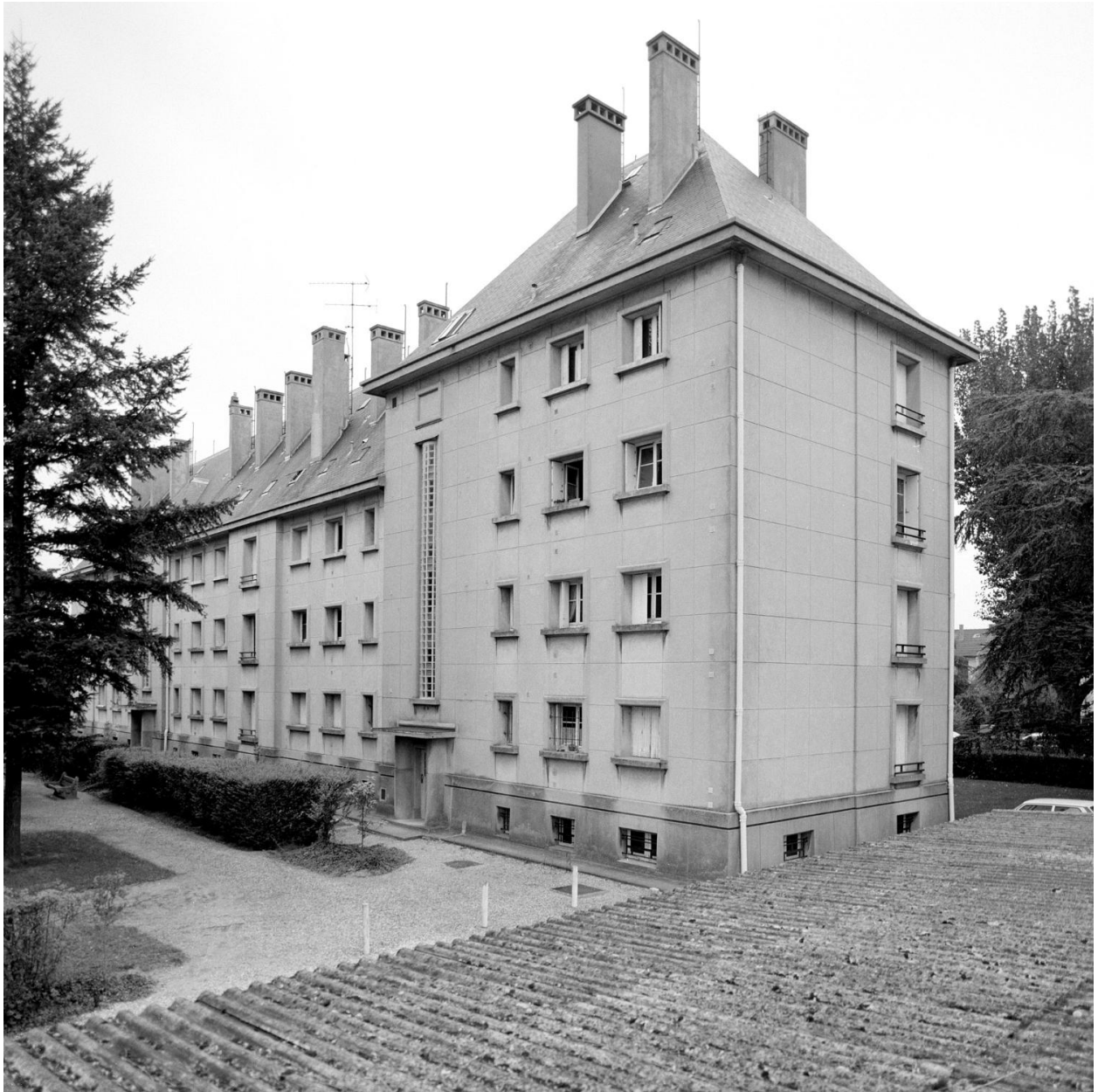
Vue perspective de l'immeuble des n° 5-7 (façade postérieure).
