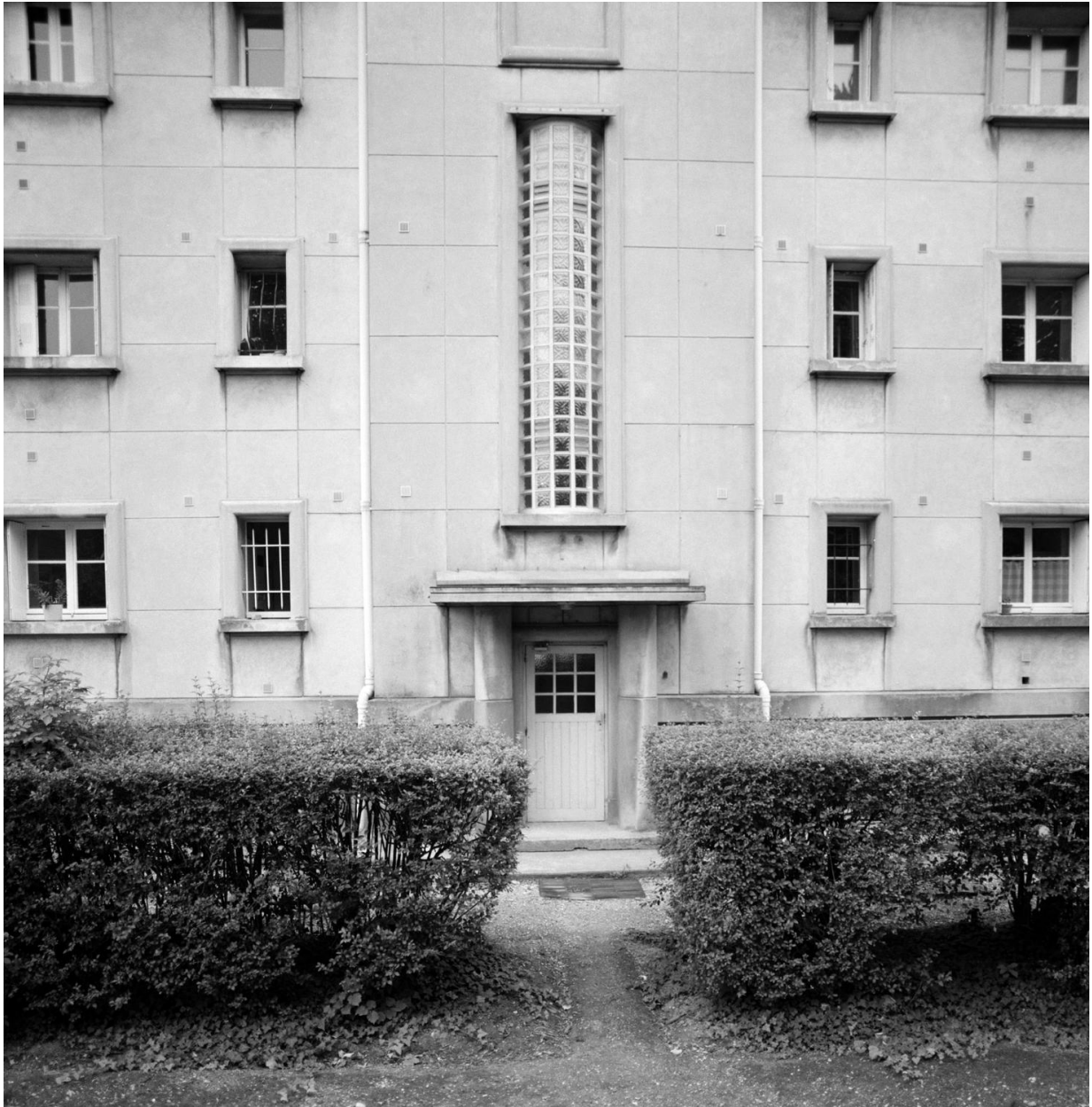
Façade postérieure de l'immeuble n° 5-7 : détail de la travée d'escalier et de sa fenêtre en pavés de verre.
