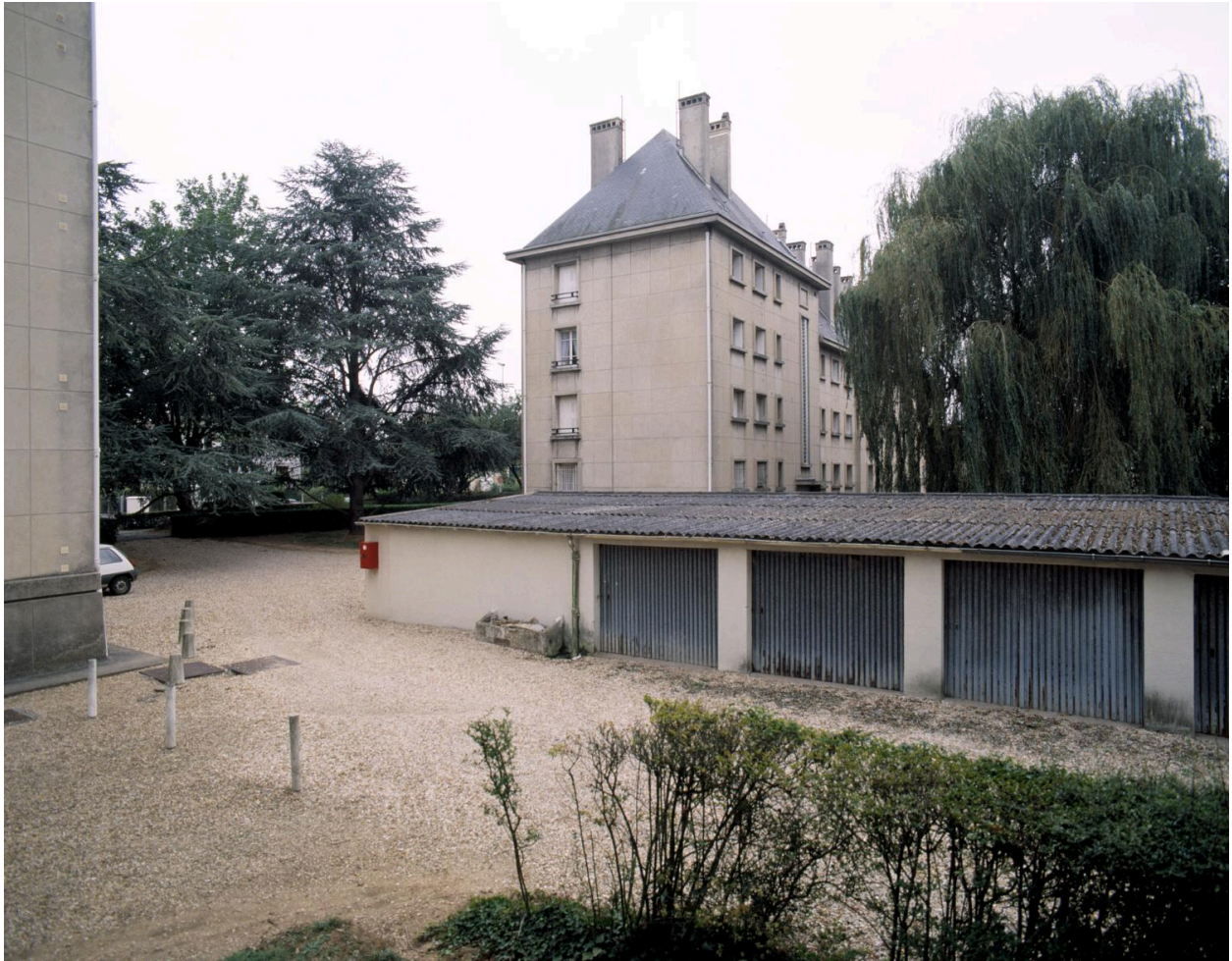
Le bâtiment des garages et le pignon de l'immeuble n° 1-3.
