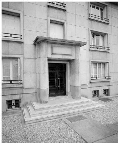
Façade antérieure du 1er immeuble : détail de la porte d'entrée (n° 3). Phot. Philippe Ayrault IVR11_20029101259X
