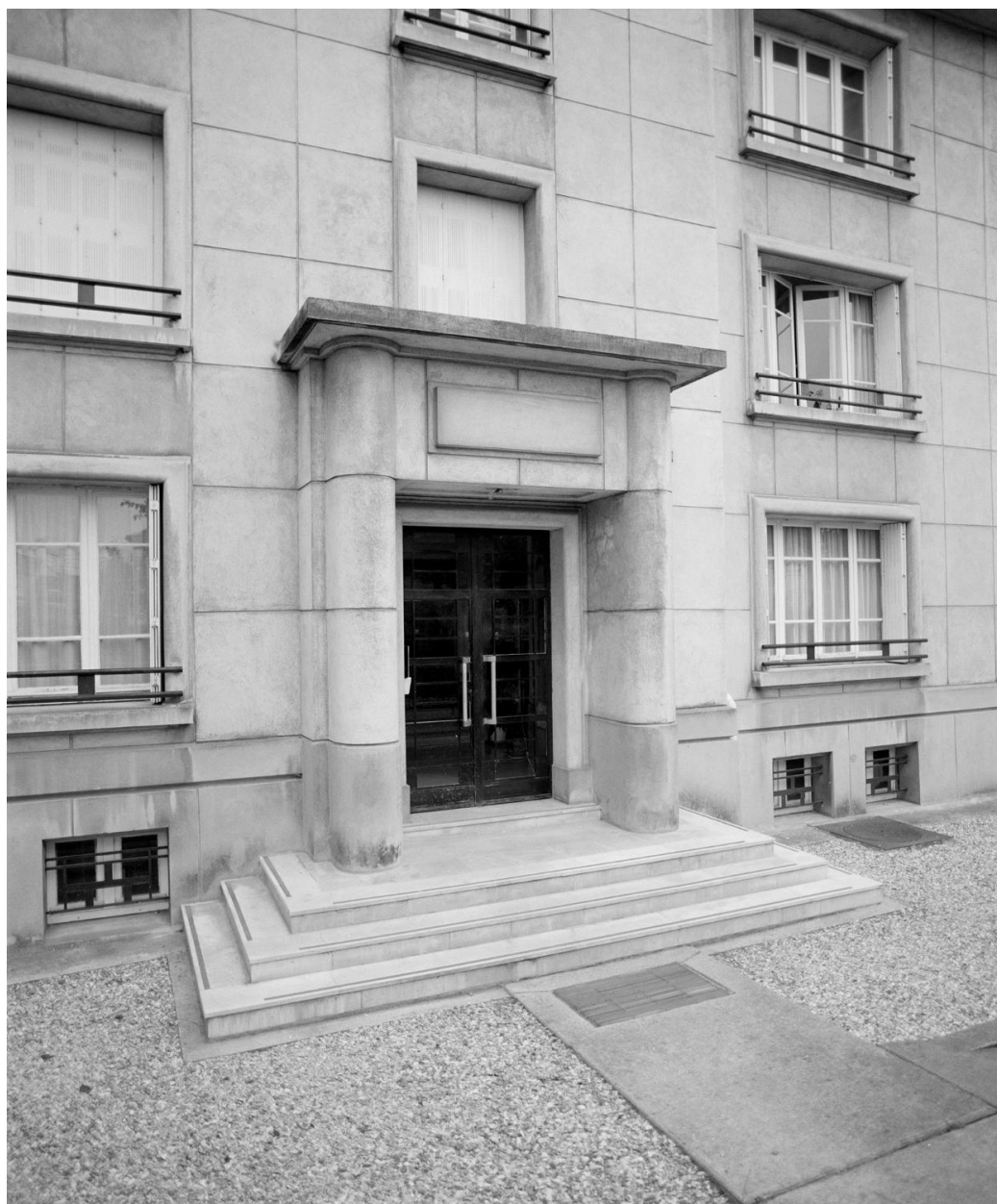
Façade antérieure du 1er immeuble : détail de la porte d'entrée (n° 3).
