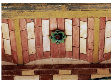
Détail des voûtains de brique au dessus de la porte d'entrée. Phot. Décamps Christian IVR11_19977800182ZA
