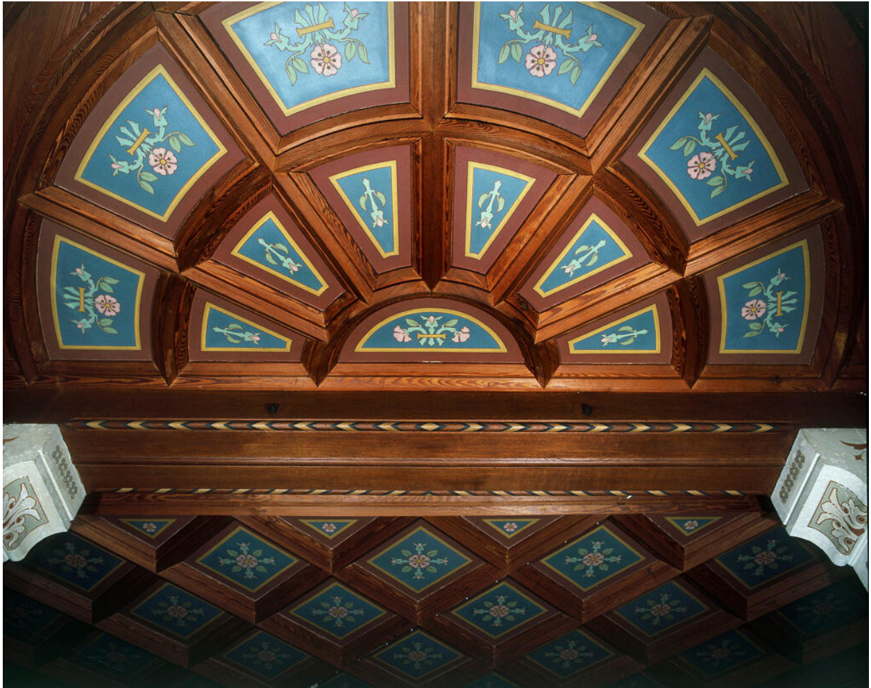
Détail du plafond à caisson du salon.
