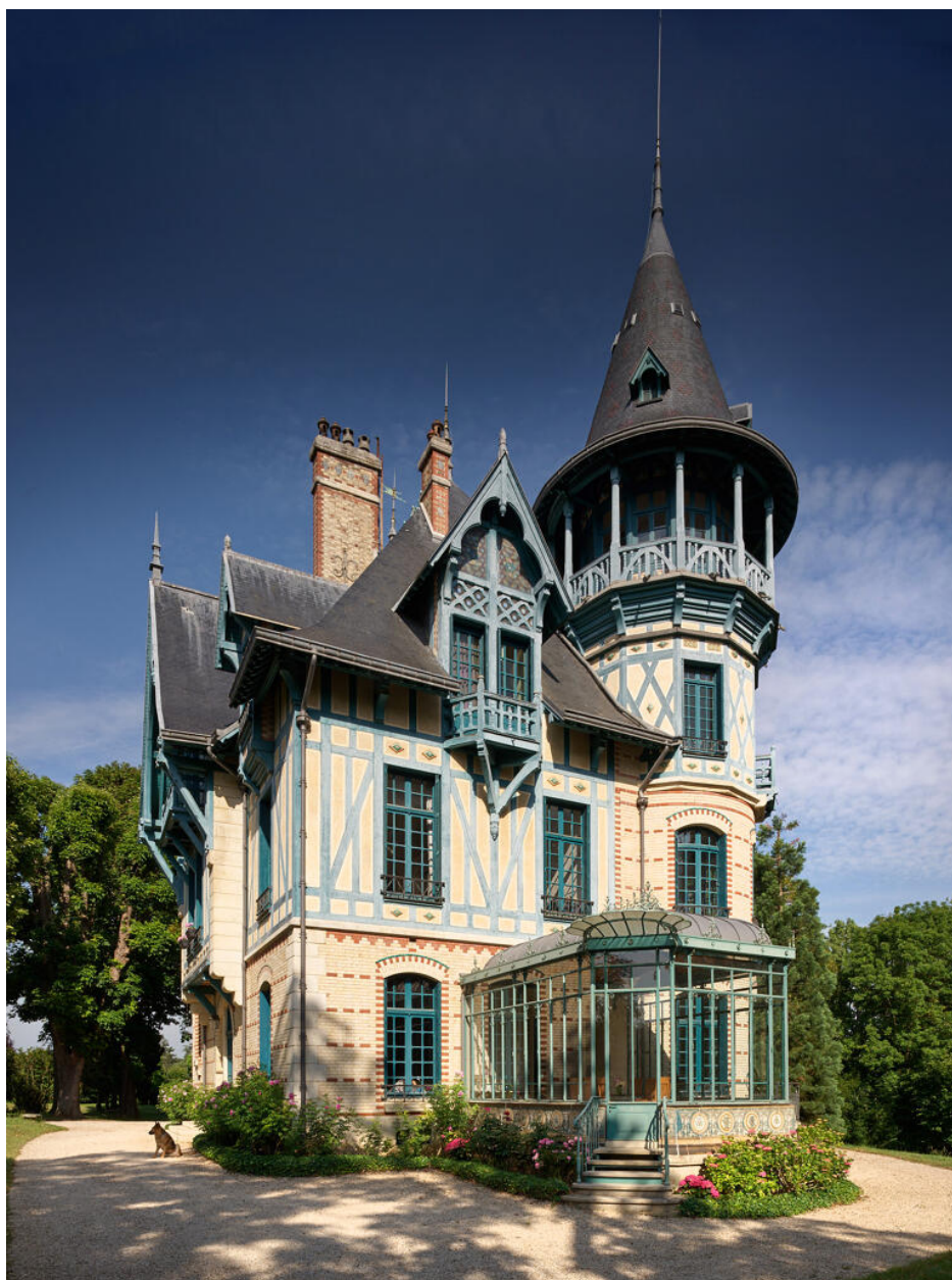
Vue générale, façade est.
