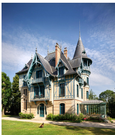
Vue d'ensemble, angle sud-est. Phot. Asseline Stéphane IVR11_20207800335NUC4A
