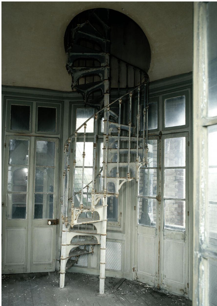
Vue de l'escalier métallique de la tour.
