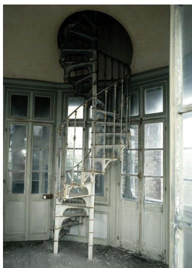
Vue de l'escalier métallique de la tour. Phot. Décamps Christian IVR11_19977800029XA
