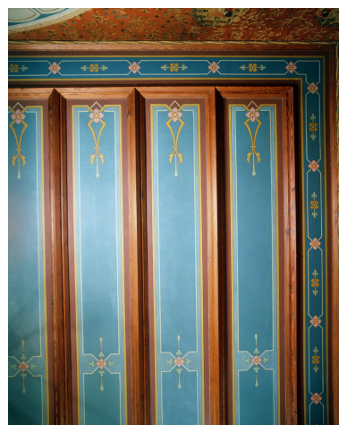
Détail du plafond peint de la salle à manger. Phot. Décamps Christian IVR11_19977800025XA
