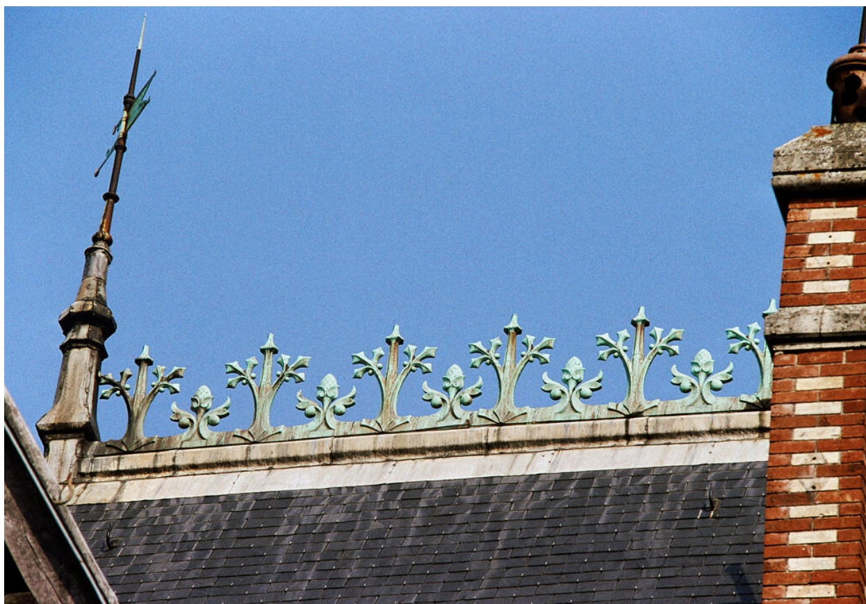
Détail des parties hautes : crête de faîtage.
