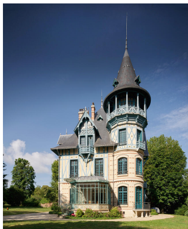
La façade est. Phot. Asseline Stéphane IVR11_20207800334NUC4A
