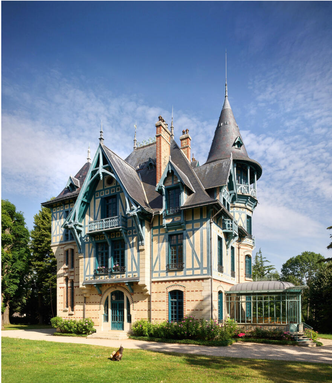
Vue d'ensemble, angle sud-est.
