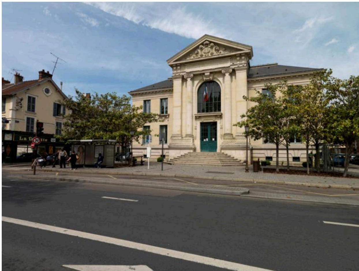
Vue d'ensemble de la façade sur la rue de la République.
