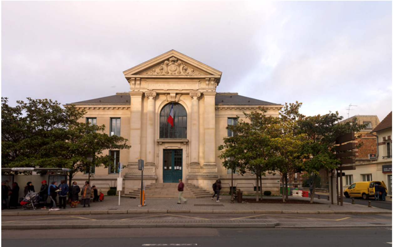
Vue de la façade.
