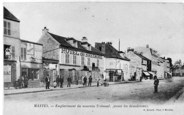
Le Palais de justice a été construit à l'emplacement de l'hôtel de Bretagne, rue Nationale. Carte postale (Région Ile-de-France, fonds CREDOP). Repro. CREDOP IVR11_20157800077X
