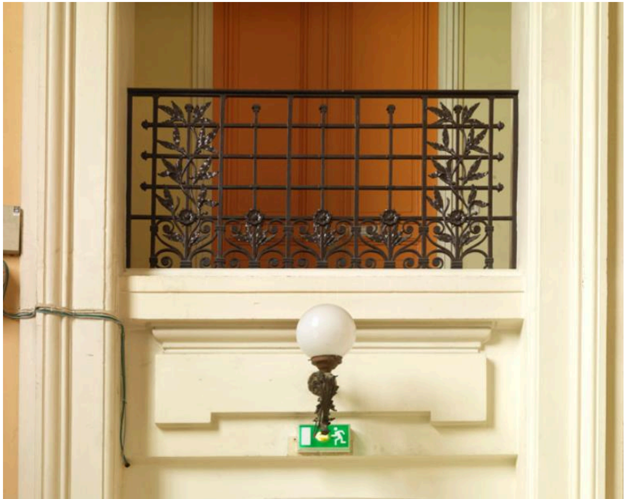
La ferronnerie de l'un des balcons de l'étage.
