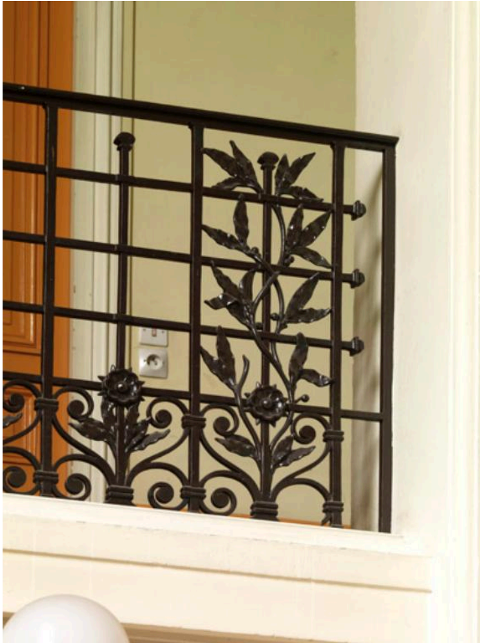
Détail de la ferronnerie d'un balcon de l'étage dont le motif est caractéristique du début du 20e siècle.
