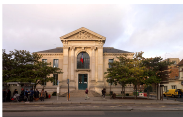
Vue de la façade. Phot. Laurent Kruszyk IVR11_20157800619NUC4A
