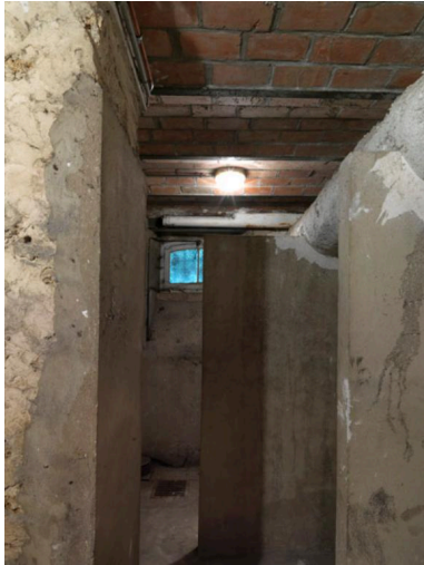
Anciennes cellules dans le sous-sol.
