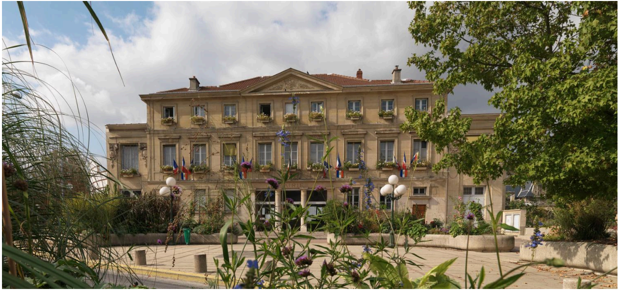
Vue de la façade principale, construite en 1873.
