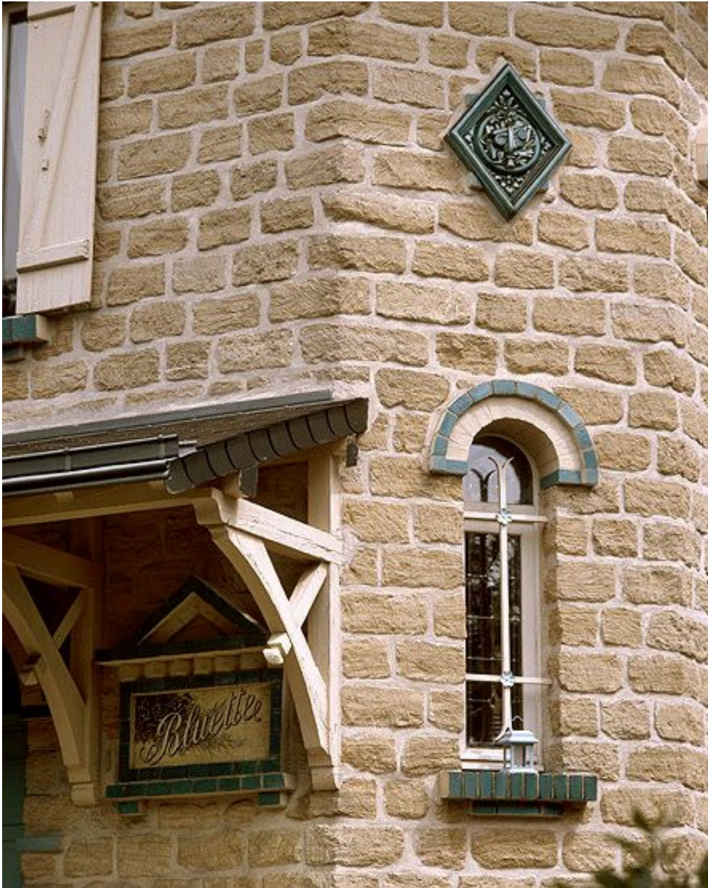
Détail du décor sur la façade latérale.
