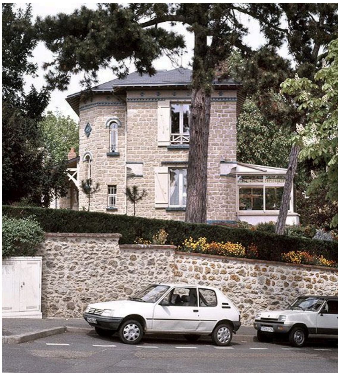
Vue d'ensemble de la façade panoramique.
