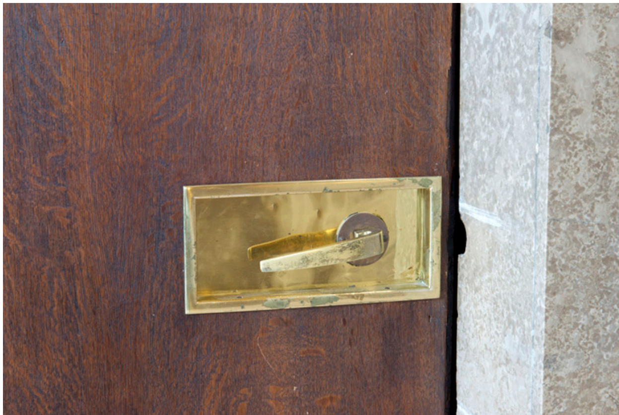
Vue de la poignée d'une porte du couloir du premier étage.
