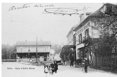
La première gare d'Athis, vue côté Seine. Elle subsistera jusqu'à la réalisation des travaux de doublement des voies en 1904. A gauche, passage à niveau qui sera remplacé par un passage inférieur. A droite, passage inférieur de 3 mètres d'ouverture conservé et rallongé après les travaux.
