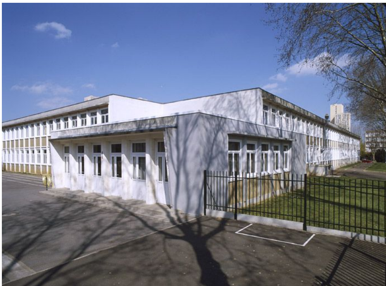
Vue d'ensemble du bâtiment à la jonction des deux ailes.
