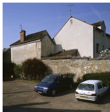
La façade arrière et le mur de clôture du jardin, ancien clos. Phot. Laurent Kruszyk IVR11_20077800138XA
