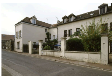
La façade sur la rue du bâtiment principal qui abritait l'école et la mairie. L'aile droite était le logement de l'instituteur. Phot. Laurent Kruszyk IVR11_20077800136XA
