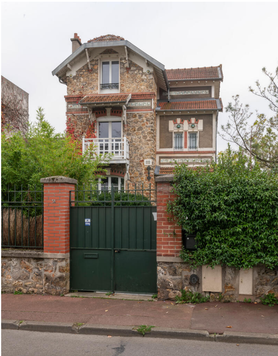
Maison d'habitation, façade principale.
