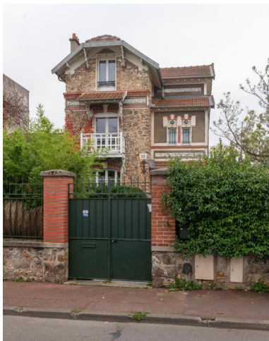
Maison d'habitation, façade principale.
