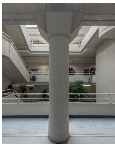
Les coursives de l'atrium et à chaque niveau, la structure en béton toujours perceptible. Phot. Philippe Ayrault IVR11_20207500853NUC4A
