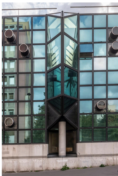
Détail de la façade sur la rue Oudiné. Rien, en apparence, ne donne à voir la vocation pédagogique des locaux, qui adoptent le vocabulaire architectural des immeubles de bureaux. Phot. Philippe Ayrault IVR11_20207500886NUC4A
