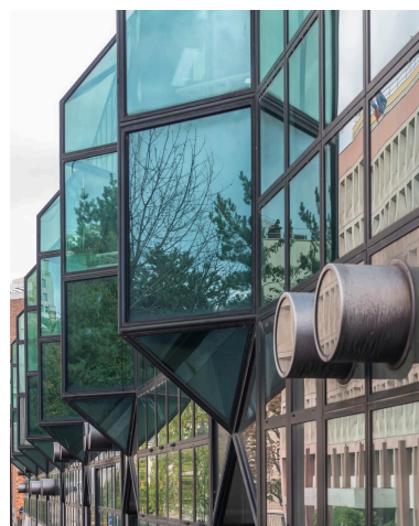
Détail de la façade côté rue Oudiné, avec ses volumes hors-œuvre correspondant aux ateliers de prothèse dentaire aujourd'hui. Phot. Philippe Ayrault IVR11_20207500885NUC4A
