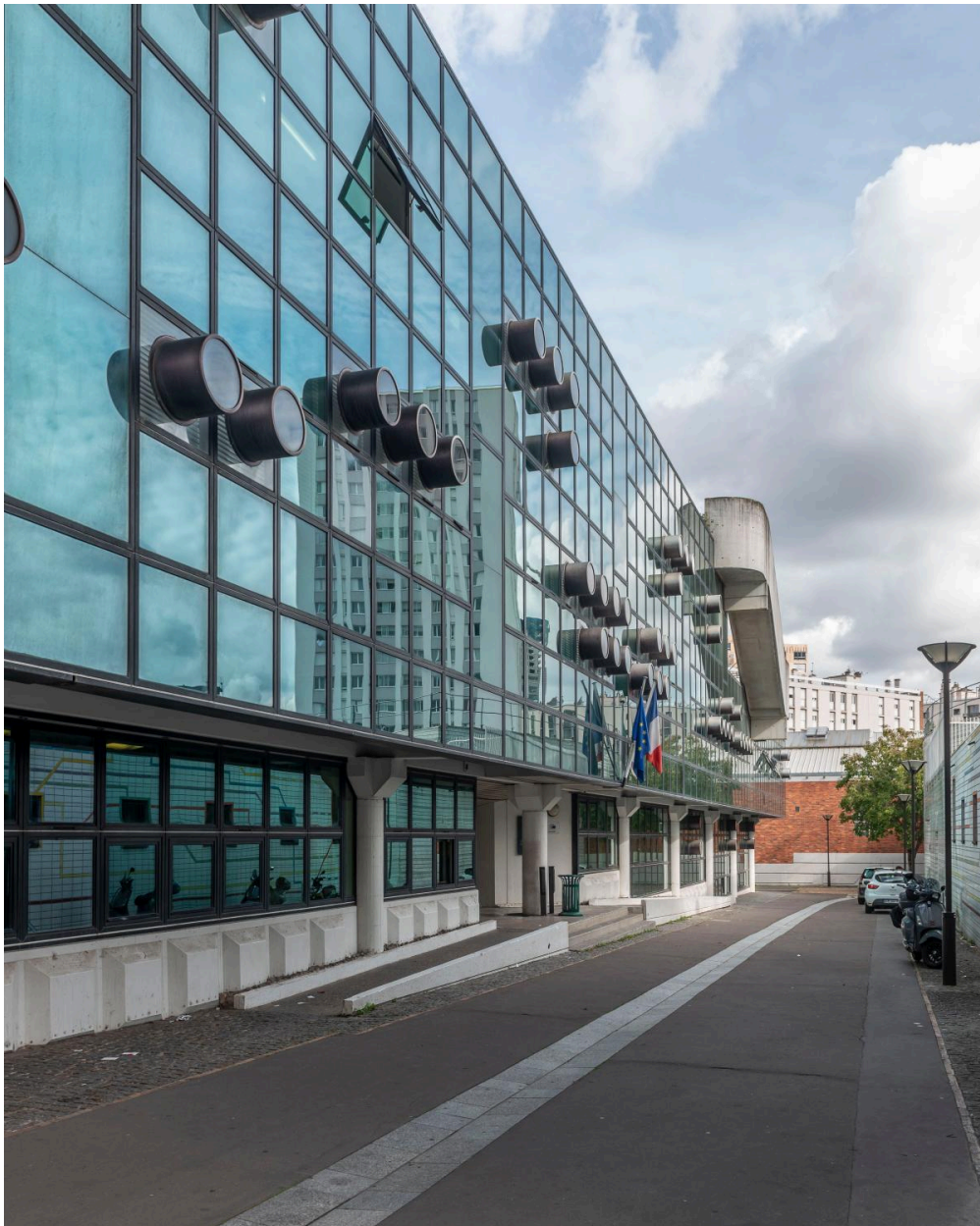
La façade du lycée côté rue intérieure.
