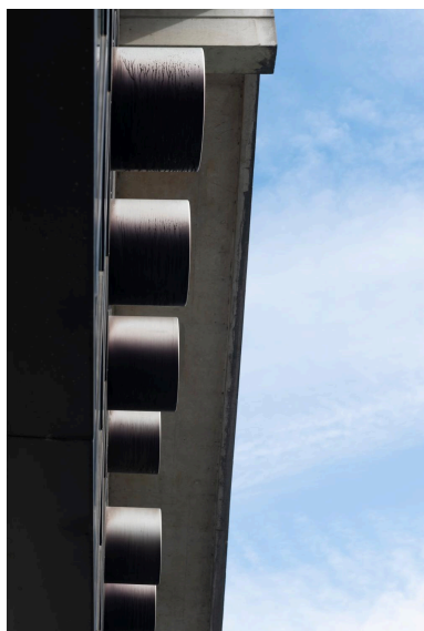
Les façades de Kalisz et Doucot s'exposent ostensiblement comme un jeu de mécano, où tous les éléments constructifs traditionnellement cachés sont mis en lumière, comme ici les fenêtres-hublots. Phot. Philippe Ayrault IVR11_20207500880NUC4A
