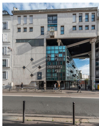
Kalisz et Doucot ont choisi le parti d'une insertion dans le tissu urbain existant : la hauteur du lycée n'excède pas celle des deux immeubles voisins entre lesquels il s'insère et respecte leurs modénatures. Phot. Philippe Ayrault IVR11_20207500828NUC4A
