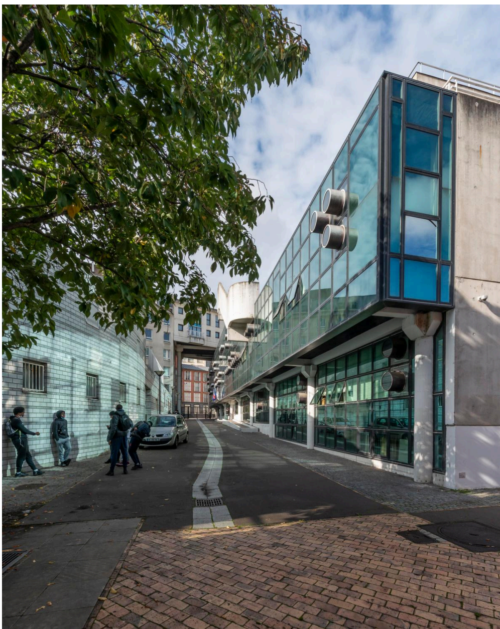
La façade du lycée du côté de la rue intérieure, au cœur de l'îlot.
