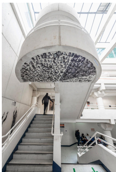
L'escalier rampe sur rampe en béton brut de décoffrage dessert tous les niveaux depuis l'atrium. Phot. Philippe Ayrault IVR11_20207500856NUC4A
