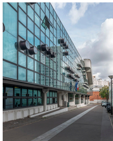
La façade du lycée côté rue intérieure. Phot. Philippe Ayrault IVR11_20207500882NUC4A
