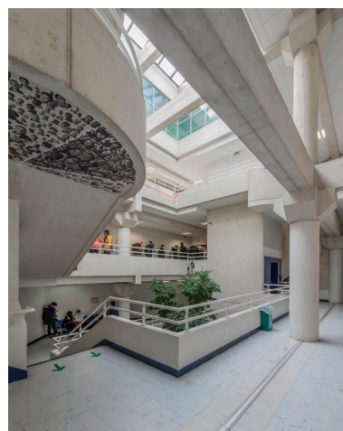
L'atrium et la verrière zénithale. Phot. Philippe Ayrault IVR11_20207500855NUC4A
