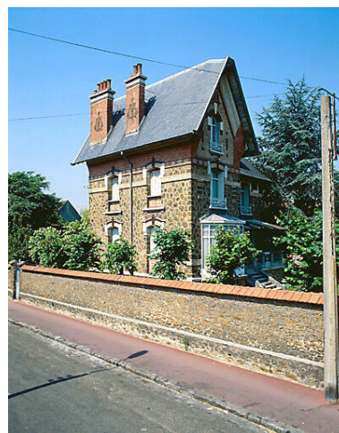
Façades latérale et antérieure. Phot. Décamps Christian IVR11_19899400130XA
