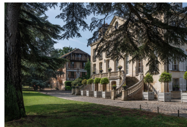
Vue d'ensemble, la maison et le chalet. IVR11_20239200013NUC4A
