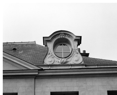
Détail d'une lucarne, façade sur jardin. Phot. Vialles Jean-Bernard IVR11_19929202758X
