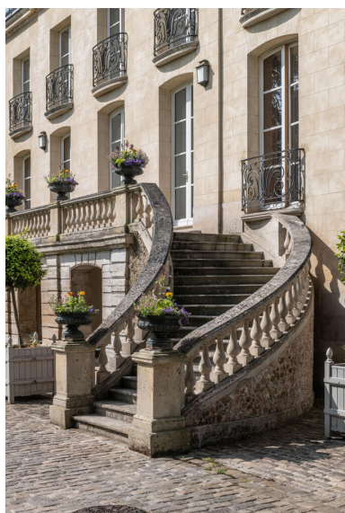
Détail de l'escalier extérieur. Le limon porte un revêtement rocaillé. IVR11_20239200017NUC4A
