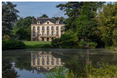
La façade principale donne sur le parc et la grande pièce d'eau. IVR11_20239200012NUC4A
