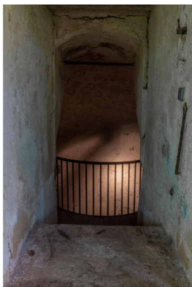
L'entrée de la glacière. IVR11_20239200025NUC4A
