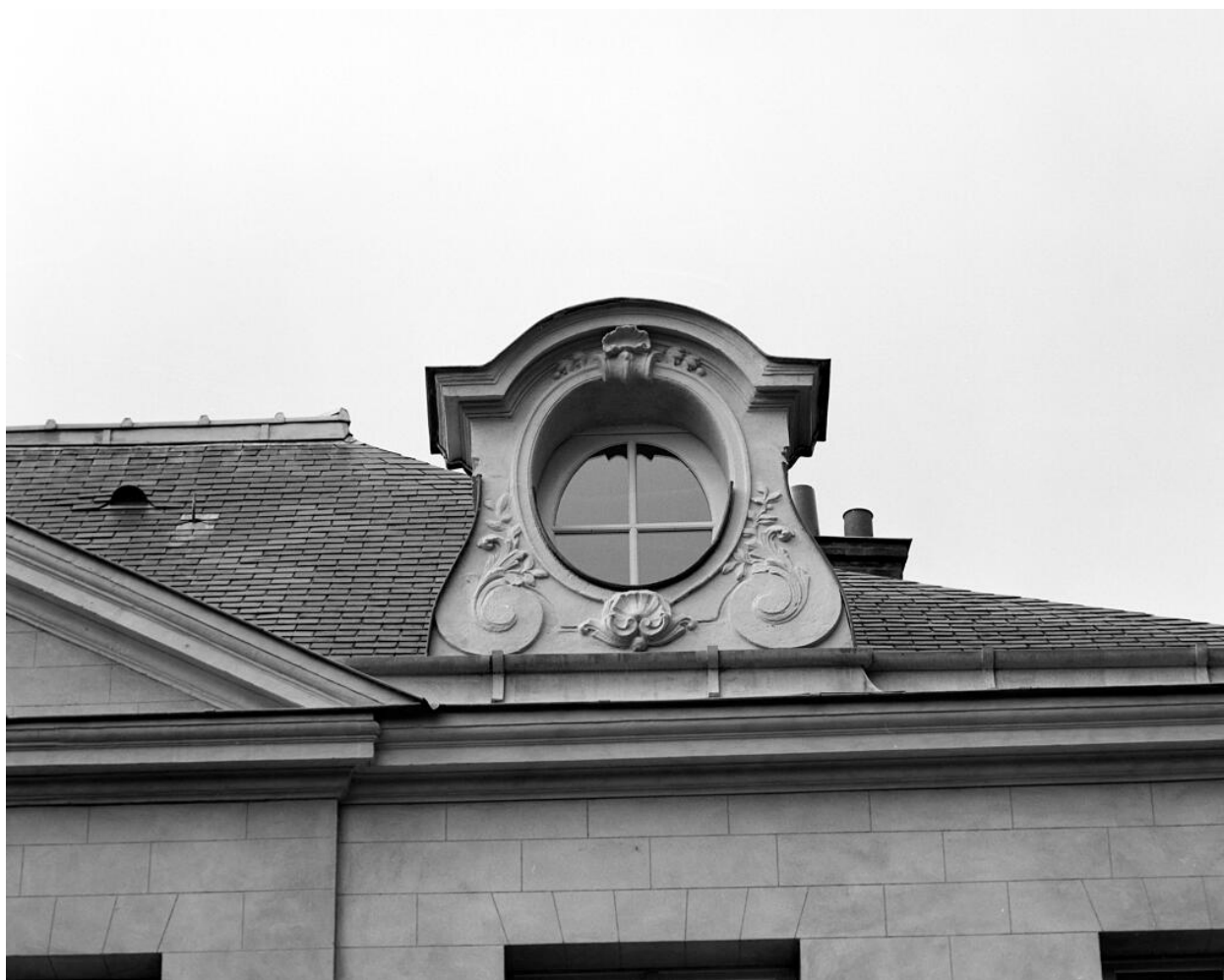
Détail d'une lucarne, façade sur jardin.
