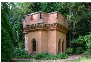
Le "déshabilleur" : petite construction romantique d'inspiration néo- gothique en brique. Elle contient une pièce carrelée. Deux couloirs enterrés rejoignent la pièce d'eau et la grotte toute proche. IVR11_20239200027NUC4A
