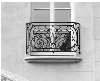
Détail d'un garde-corps en fer forgé. Phot. Vialles Jean-Bernard IVR11_19929202759X
