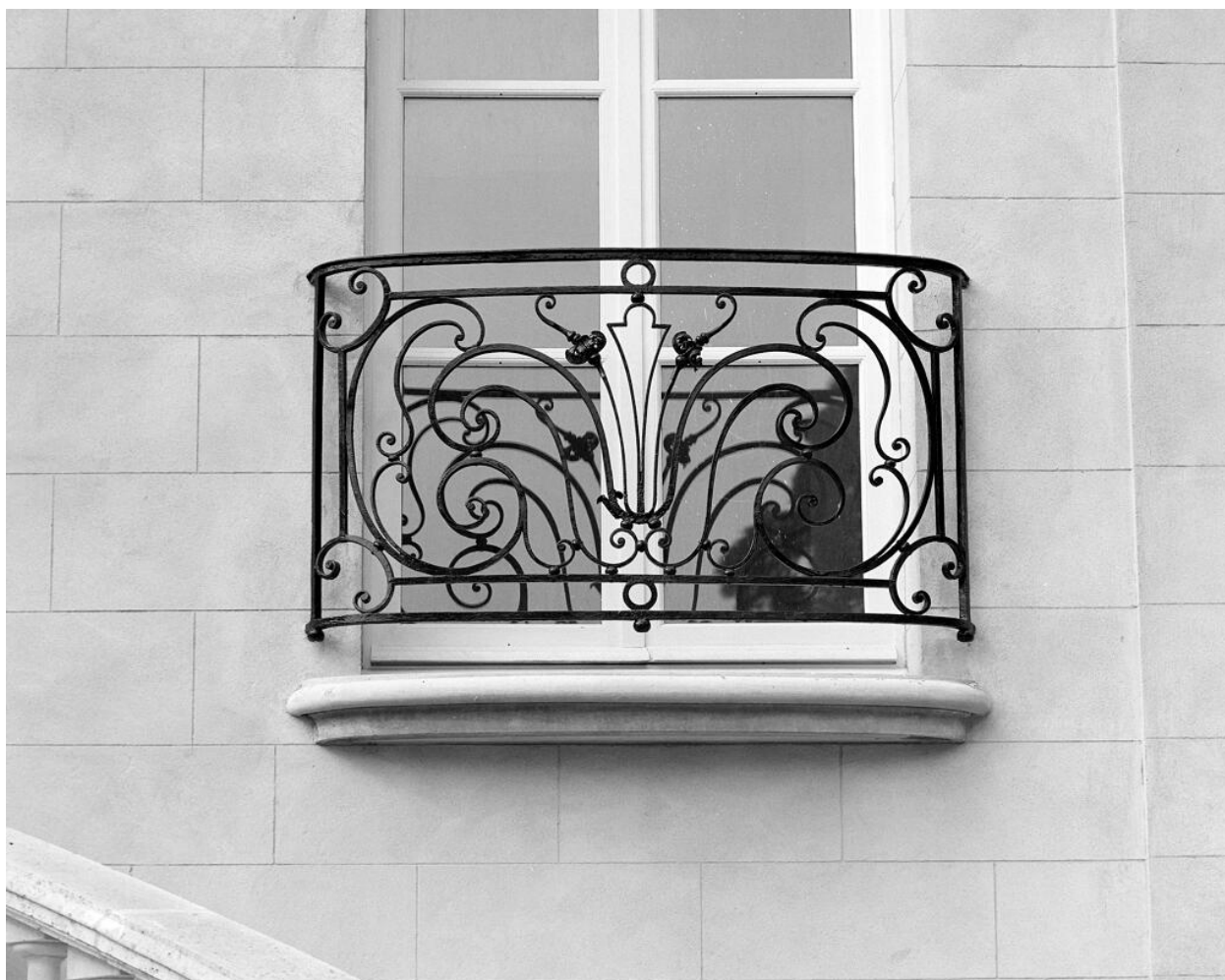
Détail d'un garde-corps en fer forgé.
