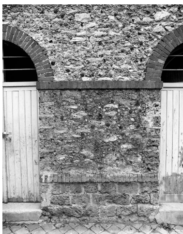
Détails de l'élévation : Brique, meulière rocaillée.
