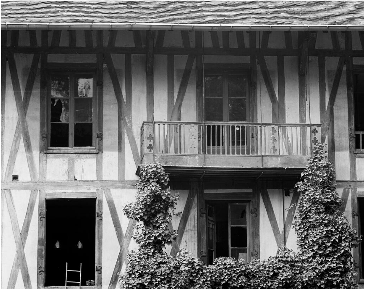
Détail de la façade sur jardin du chalet. On remarquera les pans de bois et le balcon.
