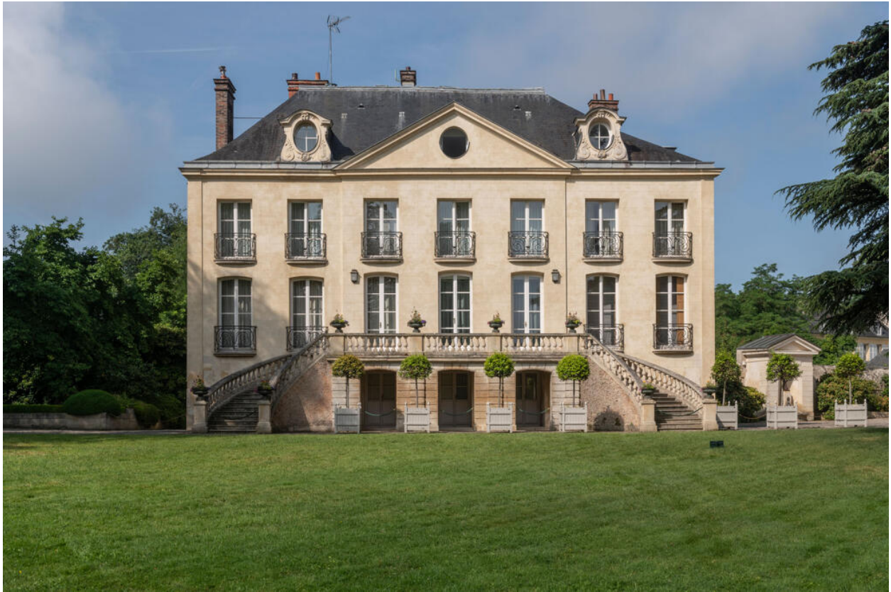
La façade principale, sur le parc. A droite, la fontaine ; à gauche, hors champ, le chalet.
