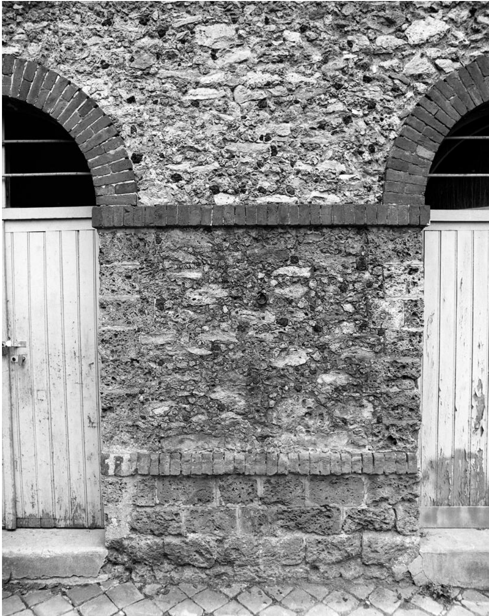
Détails de l'élévation : Brique, meulière rocaillée.
